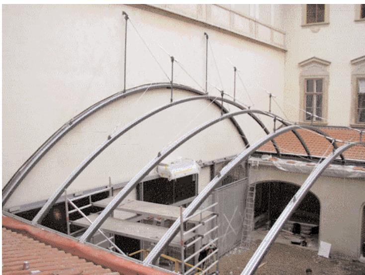
1 nosná konstrukce po předepnutí
