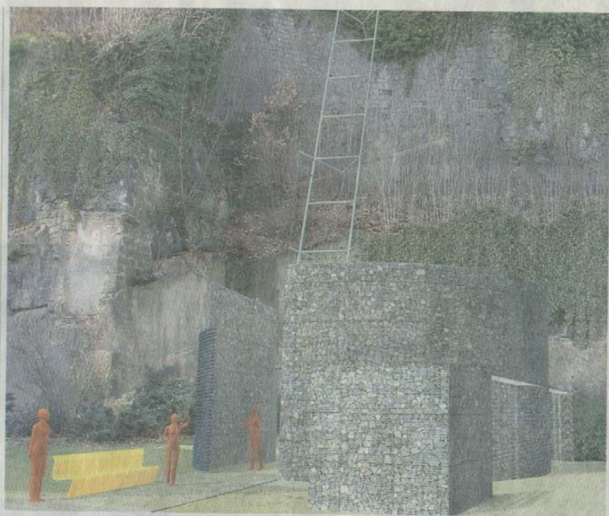
JAK BUDE VYPADAT VÝTĚH NA PASTÝŘSKOU STĚNU. Na snímku vlevo je znázorněn vchod k výťahu, nad kterým je vidět ocelová konstrukce, po které bude stroj stoupat. Vpravo celkový pohled.
