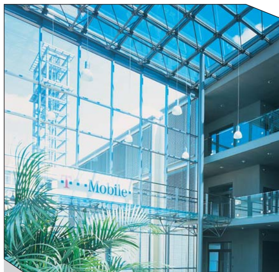
Zastřešení dvorany Roofing of the Hall
