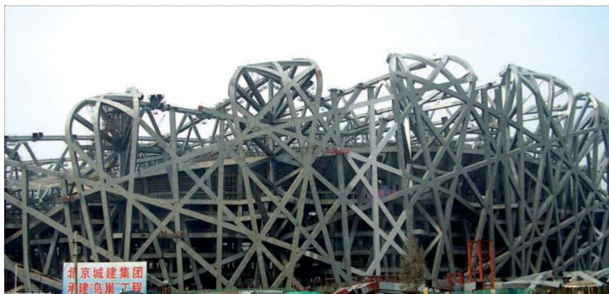
National Stadium – montáž ocelových konstrukcí
