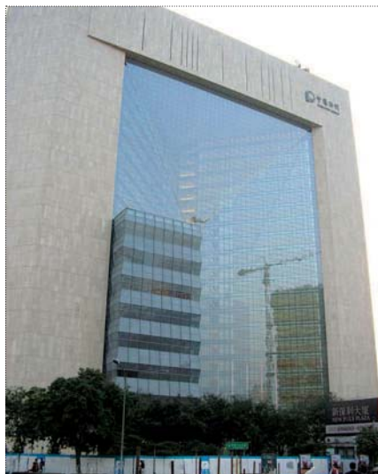
New Beijing Poly Plaza se skleněnou fasádou o rozměrech 90 × 60 m – největší na světě
