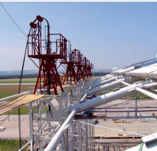
Zdvihové jednotky na vrcholech sloupů
