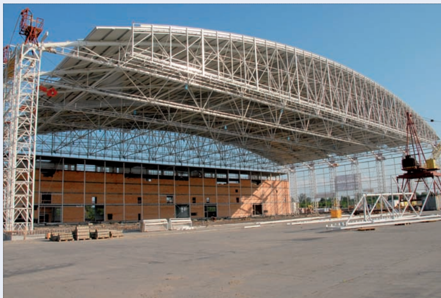
Ocelová konstrukce hangáru na letišti Ostrava-Mošnov, čelní pohled
