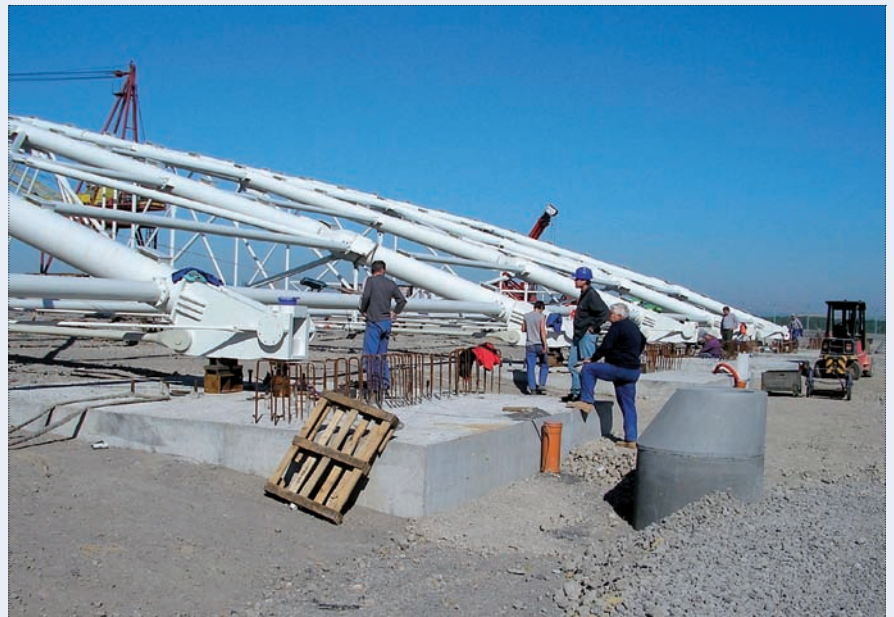
Aktivace konstrukce zvednutím konců vazníků
