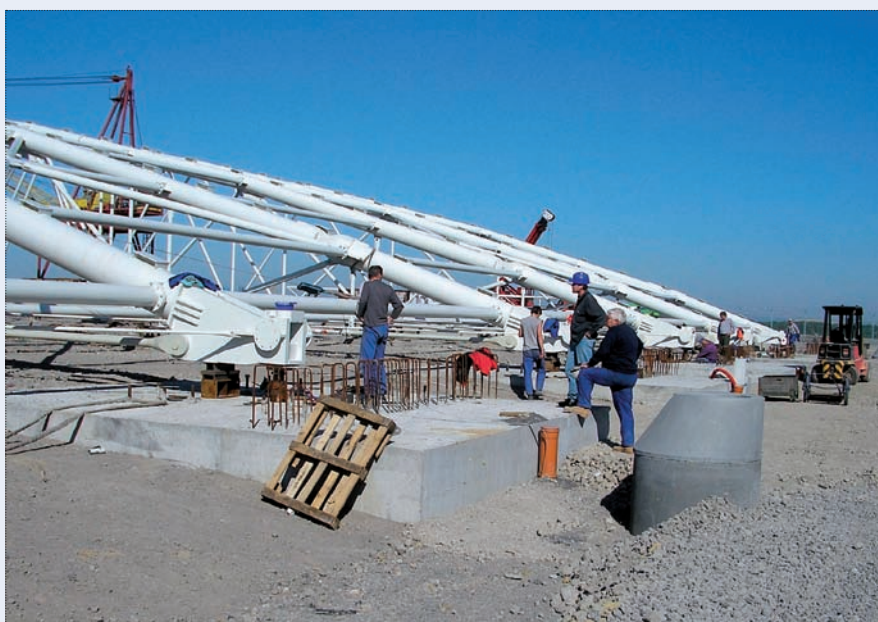
Aktivace konstrukce zvednutím konců vazníků
