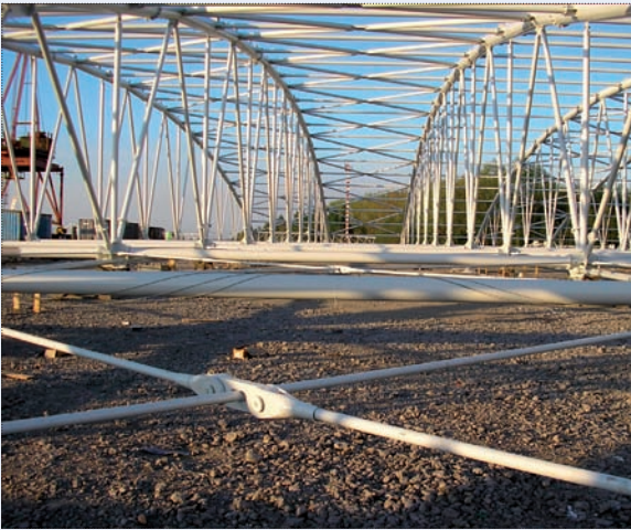
Horní (trubkové) a spodní (předpjatá táhla M48) úroveň ztužení
