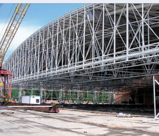
Konstrukce při zdvihu – nadvrátový nosník
