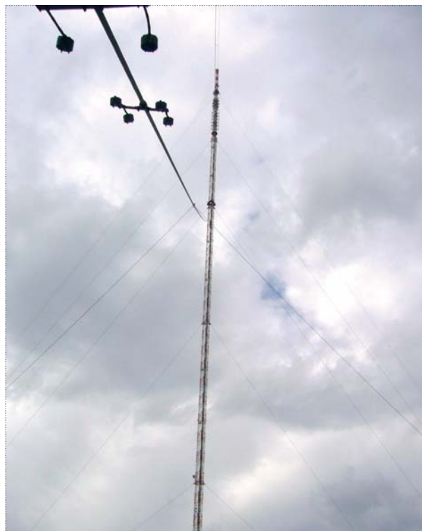
Obr. 2 – Pohled na stožár Krašov
