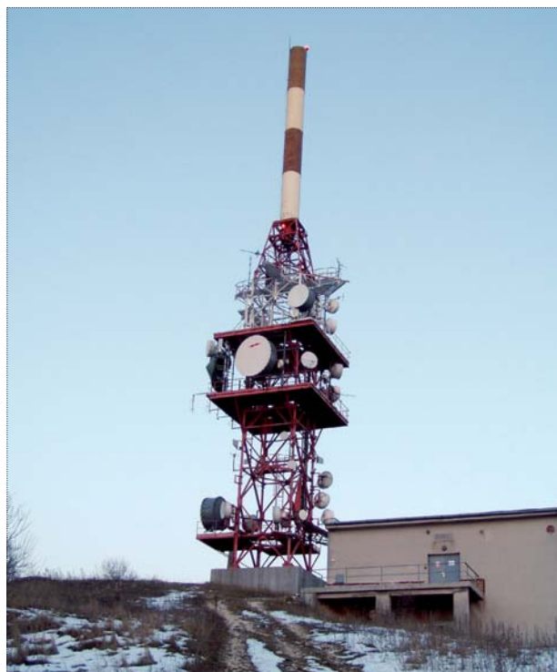
Obr. 1 – Laminátový nástavec stožáru Děvín
