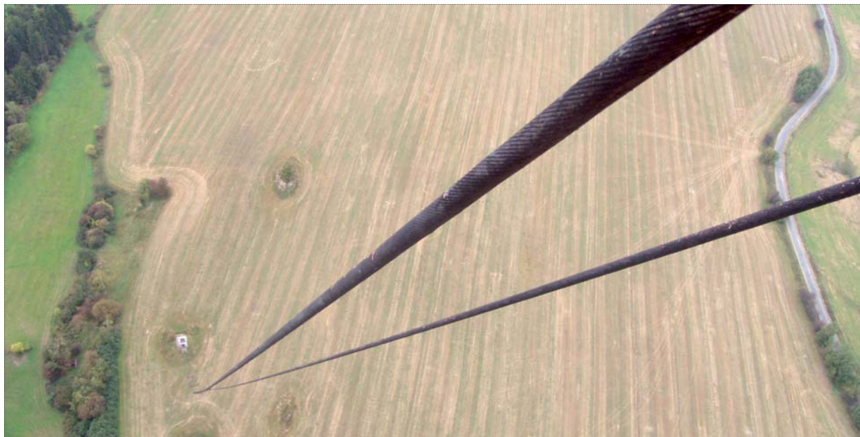
Obr. 3 – Horní dvojice kotevních lan – stožár Krašov
