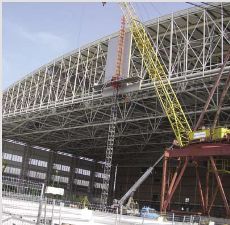
▼ Montáž štítového opláštění
