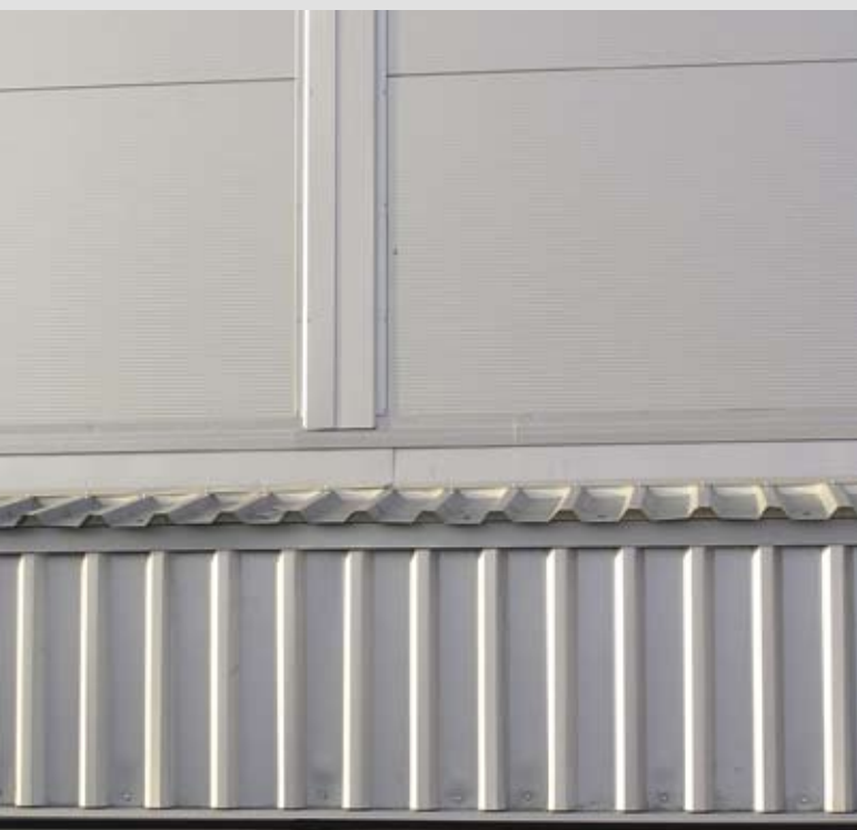
▼ Dilatační detail po opláštění
