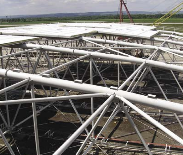
▲ Montáž střešních panelů
