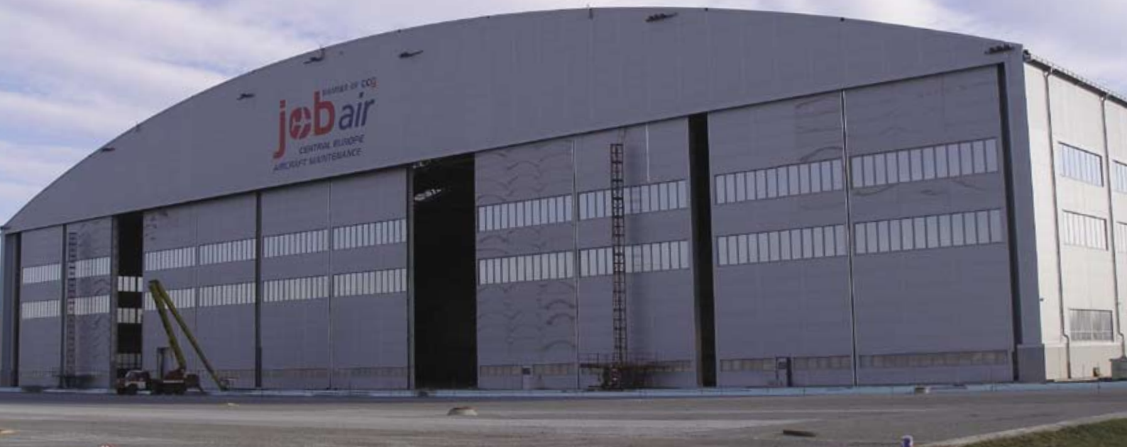
▲ Čelní pohled po opláštění vrat
