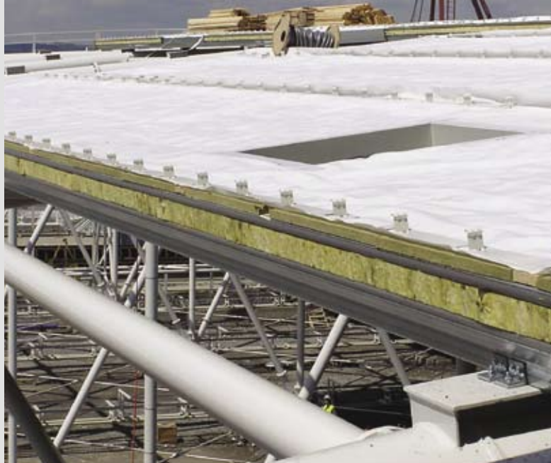
▲ Detail střešních panelů a kotvení
