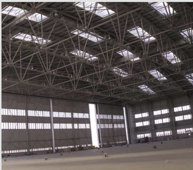
▲ Vnitřní pohled po dokončení opláštění
