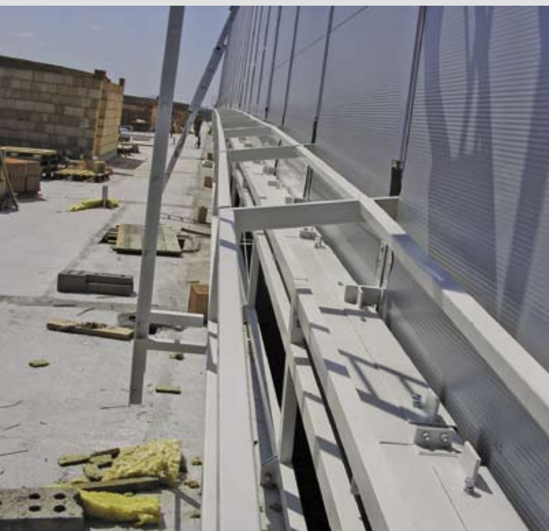
▲ Konstrukční část dilatačního detailu
