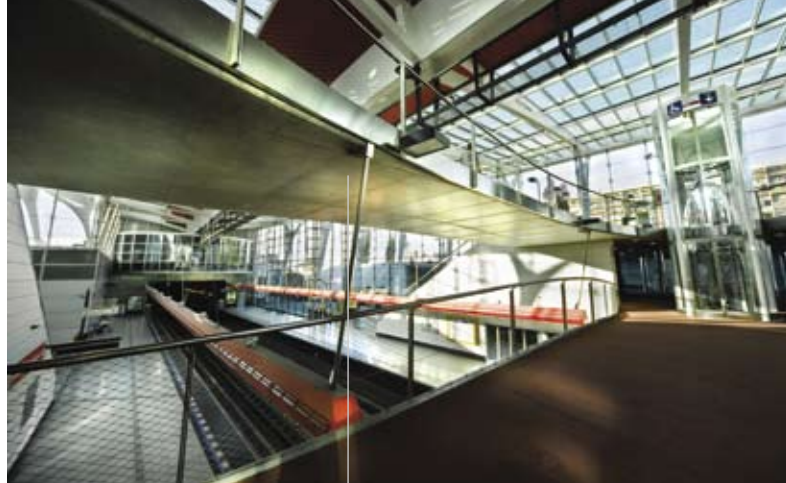
▲ Horní a spodní lávka příčně propojují stanici s vnějším prostorem
