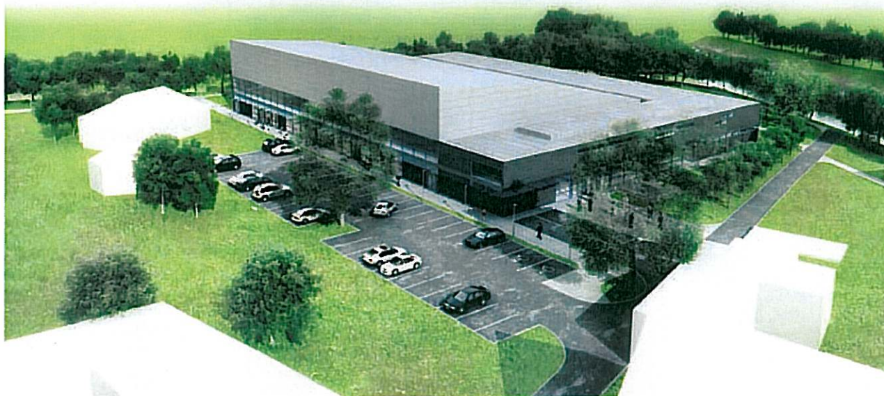
Zimní stadion ve Světlé nad Sázavou po rekonstrukci
