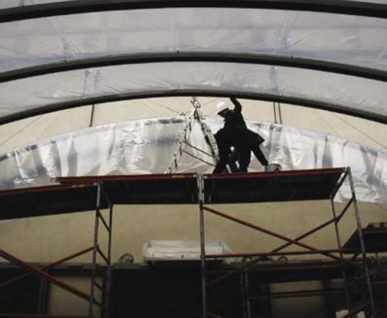
▲ Obr. 5. Zastřešení hospodářského dvora Nosticova paláce, montáž ETFE polštářů
