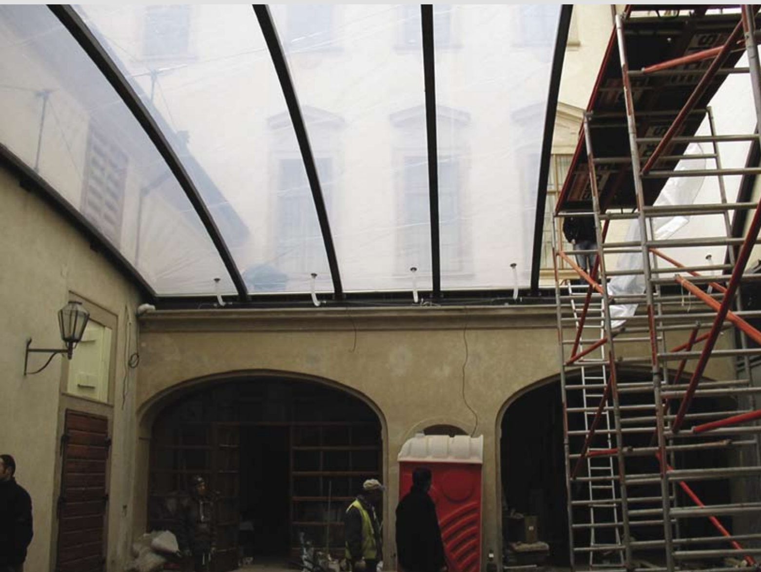
▼ Obr. 6. Zastřešení hospodářského dvora Nosticova paláce, montáž ETFE polštářů
