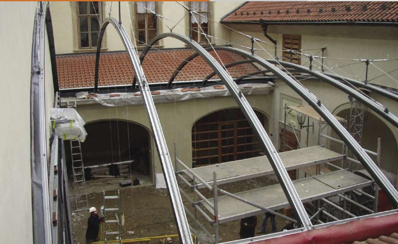
▲ Obr. 1. Konstrukce zastřešení během aktivace
