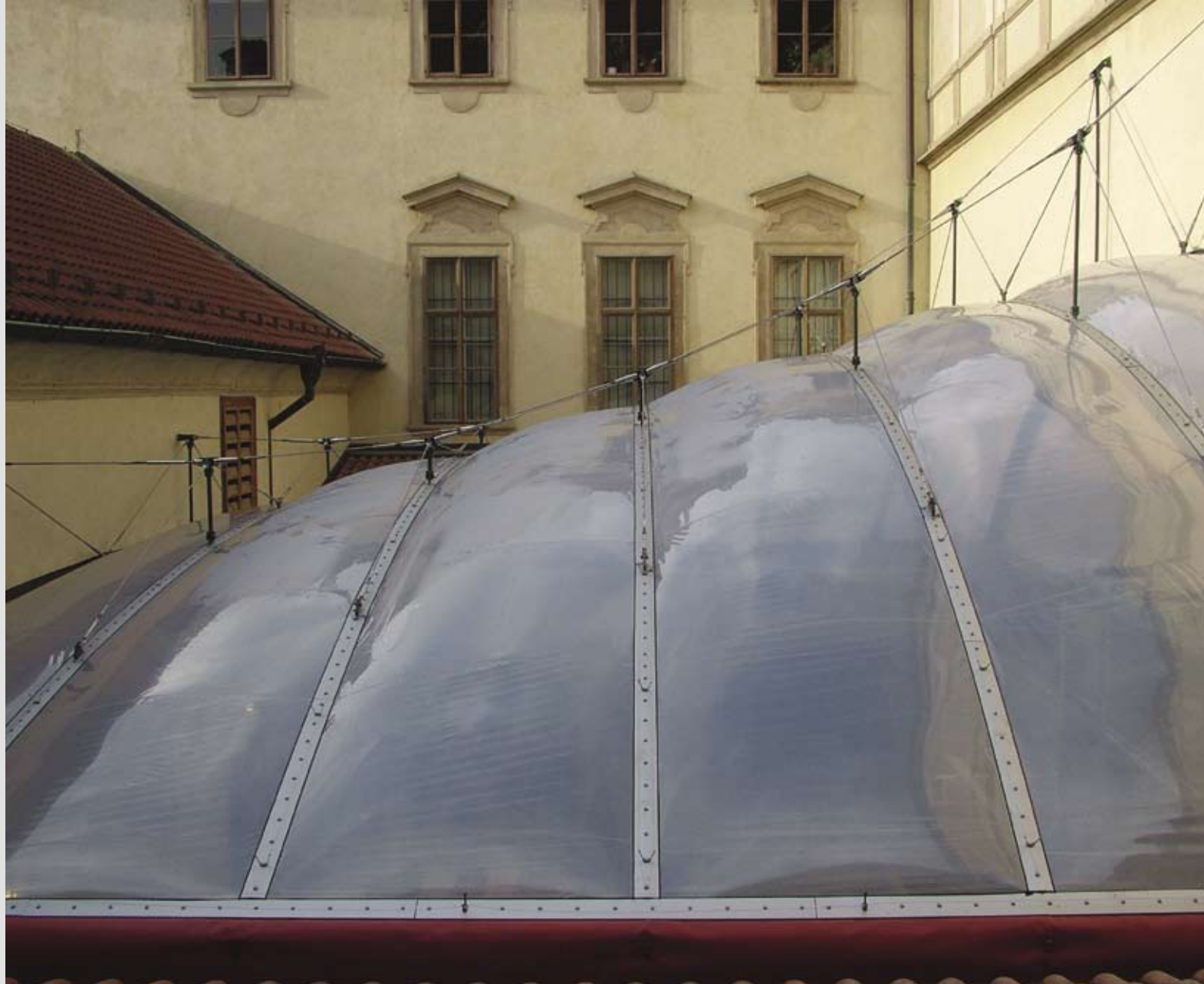
▲ Obr. 7. Dokončené zastřešení hospodářského dvora
