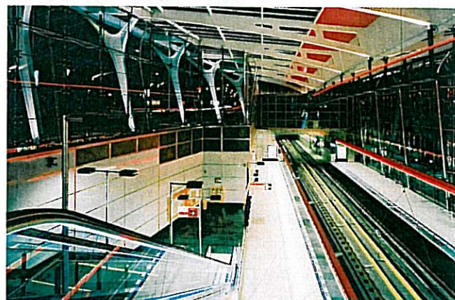
Interiér stanice metra Střížkov
