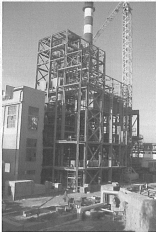
Konstrukce OK HVB před zahájením montáže OK strojovny
