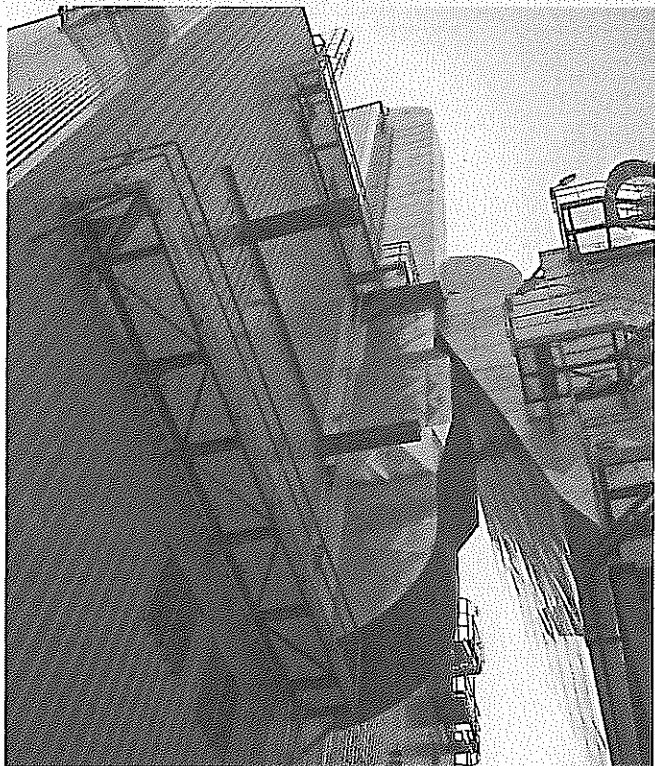
Výstupní plošky a konce jeřabových drah
