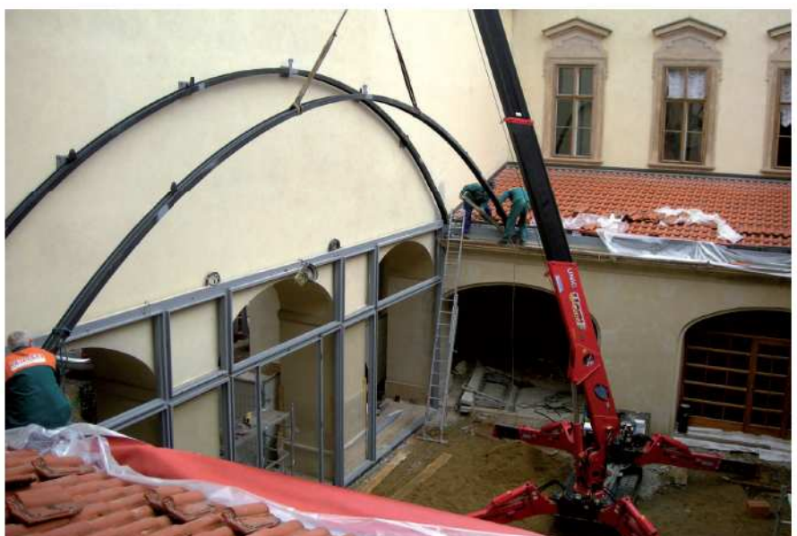
Montáž svařovaných H profilů (oblouků)
