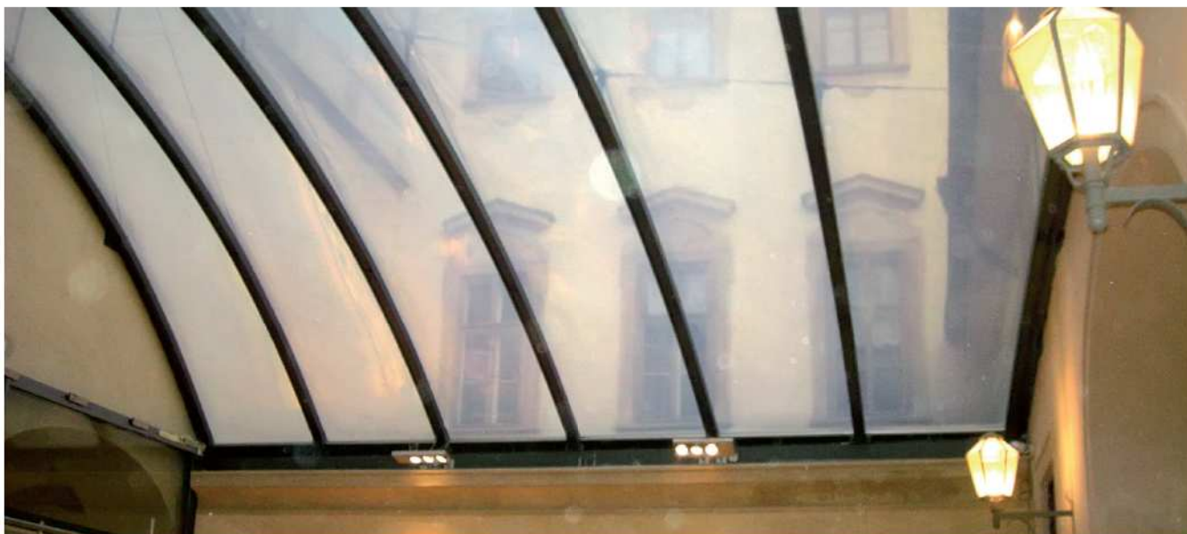
OK střechy s již instalovanou přetlakovou ETFE fólií
