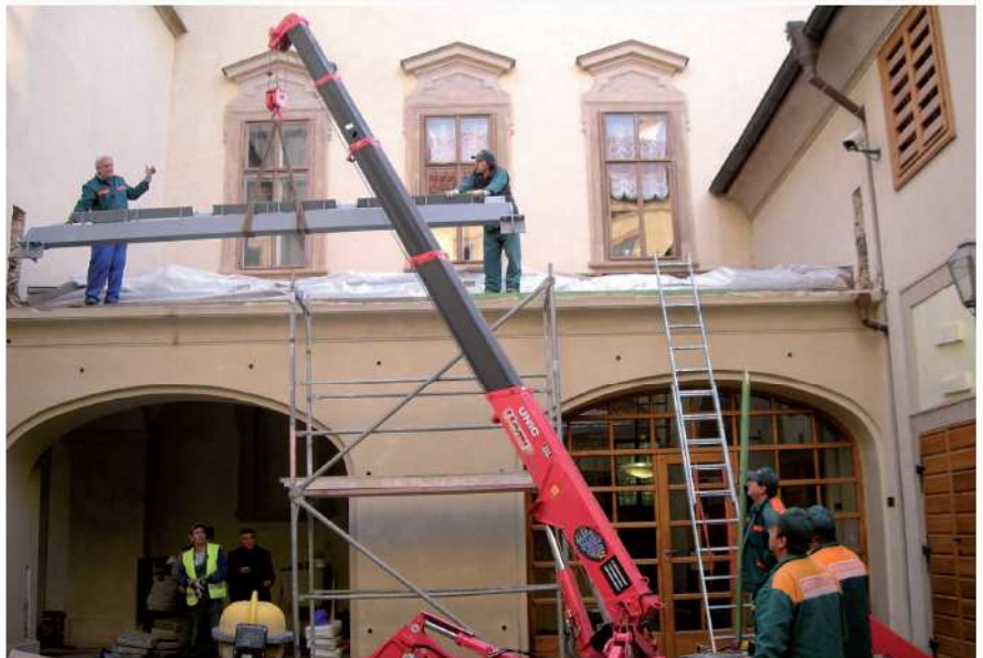
Montáž ocelové konstrukce pozednice
