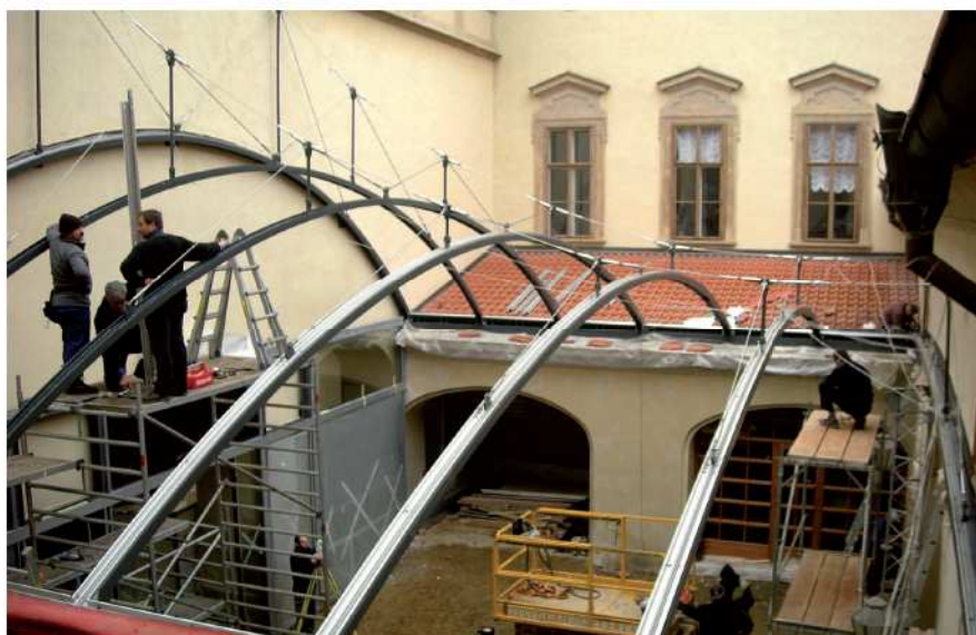
Nosná OK před zahájením předepínání
