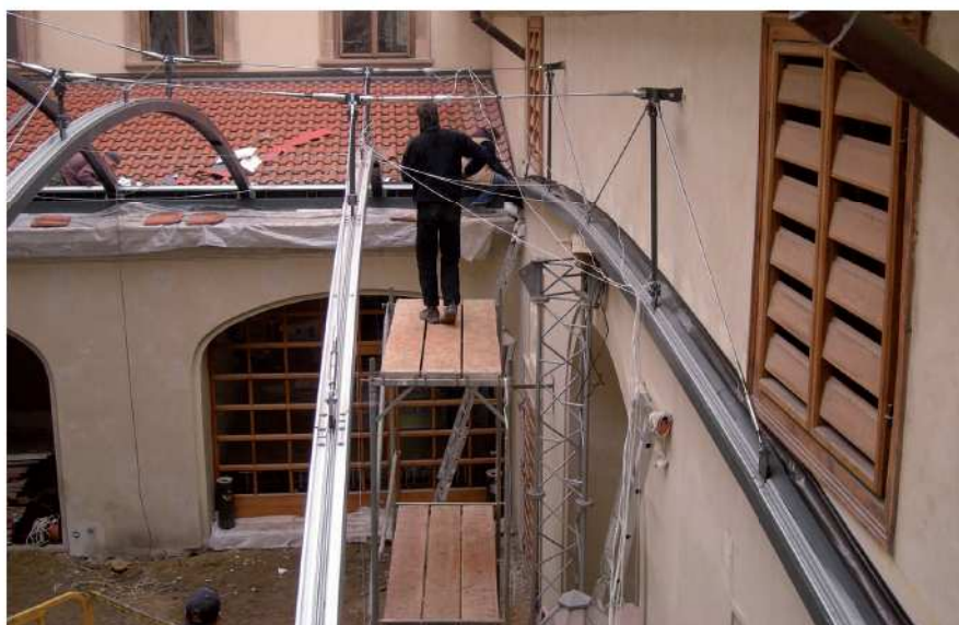
Předepínání ocelové konstrukce pomocí nerezových lan Macalloy a tenzometrů
