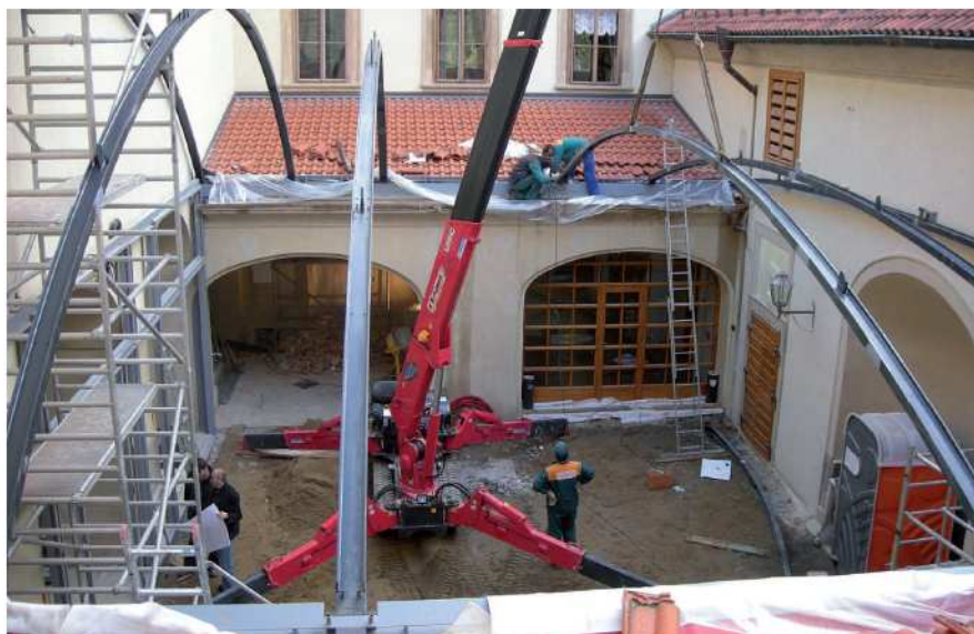
Montáž oblouků za pomoci minijeřábu
