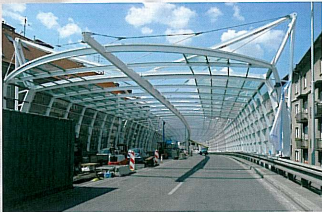
Nosná ocelová konstrukce protihlukového tunelu Hradec Králové
