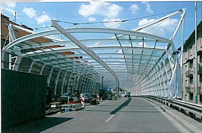
Nosná ocelová konstrukce protihlukového tunelu Hradec Králové
