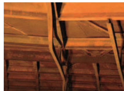
Obr. 6 – Imperfekce spodních pasů příhradových nosníků pod radiálními nosníky
