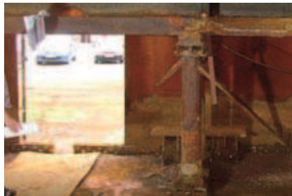
Obr. 3 – Stavající stav – zvon plynojemů je spuštěný a uložený na provizorních podporách
