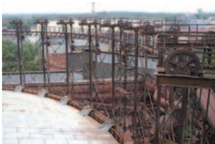
Obr. 3 – Stavající stav – zvon plynojemů je spuštěný a uložený na provizorních podporách
