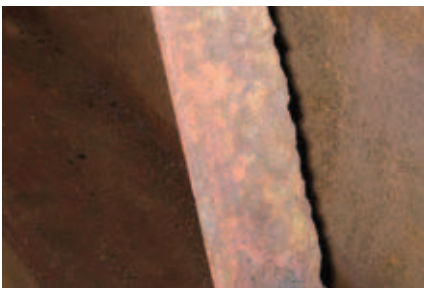
Obr. 7 – vlevo – důlková koroze na stěnových diagonálách, vpravo – kontrola ocelové konstrukce
