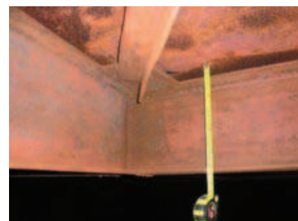
Obr. 5 – vlevo – korozní poškození v místě styku sloupu se spodním kruhovým prstencem, vpravo – střešní plášť není přivařený ke střešním nosníkům
