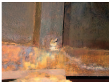
Obr. 5 – vlevo – korozní poškození v místě styku sloupu se spodním kruhovým prstencem, vpravo – střešní plášť není přivařený ke střešním nosníkům
