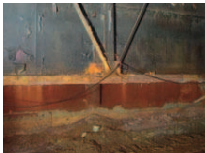
Obr. 4 – Konstrukce před a po mechanickém očištění
