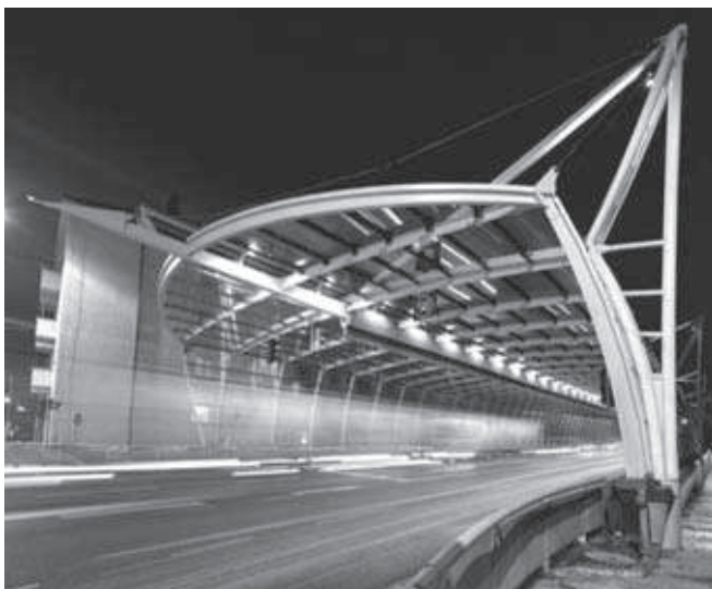
Obr. 12 – Protihlukový tunel Hradec Králové
