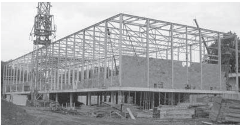
Obr. 9 – Tělocvična Univerzity Parubice; štíhlá betonová konzola nesena táhly ve stěnách
