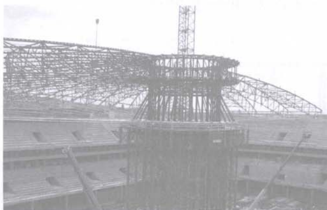
Obr. 1: Montáž na provizorní podpoře
