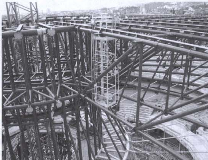
Obrázek 7. Šroubovaný styk vazníku a tubusu
