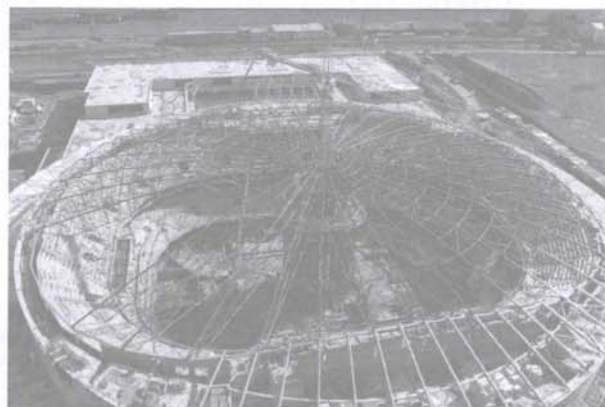
Obr. 2: Montáž - celkový pohled
