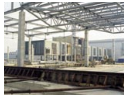
Konstrukce strojoven vzduchotechniky
