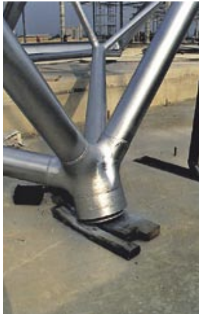
Kloubový přípoj střešních vazníků ke stromu
