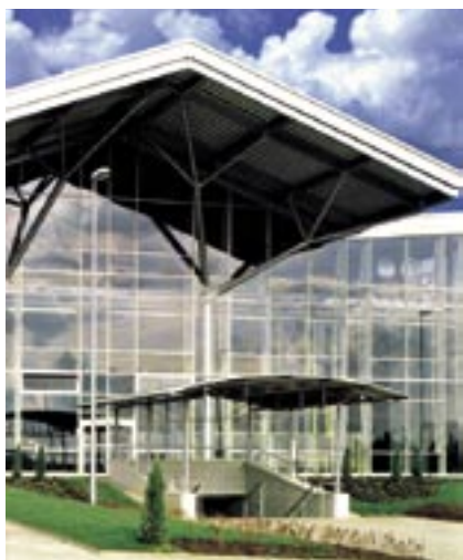
Pohled na hotovou štítovou stěnu střední části haly
