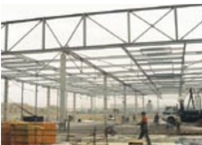
Příhradový nosník ve styku obou částí haly M13, pohled na vzpínadla
