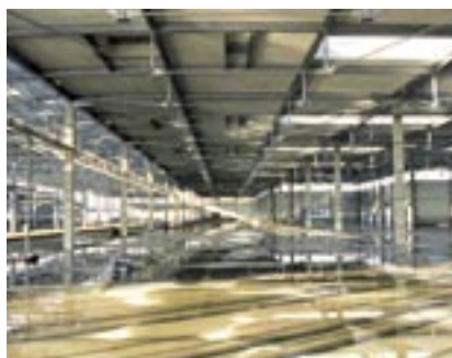
Pohled do „fraktálové“ části
