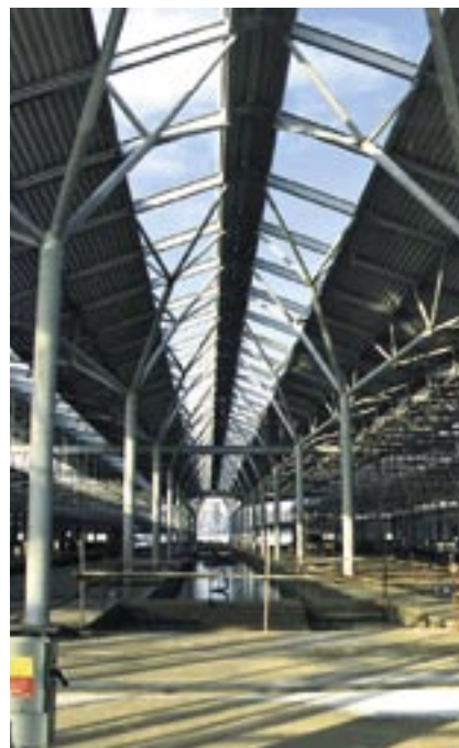
„Stromová konstrukce“ střední části haly M13
