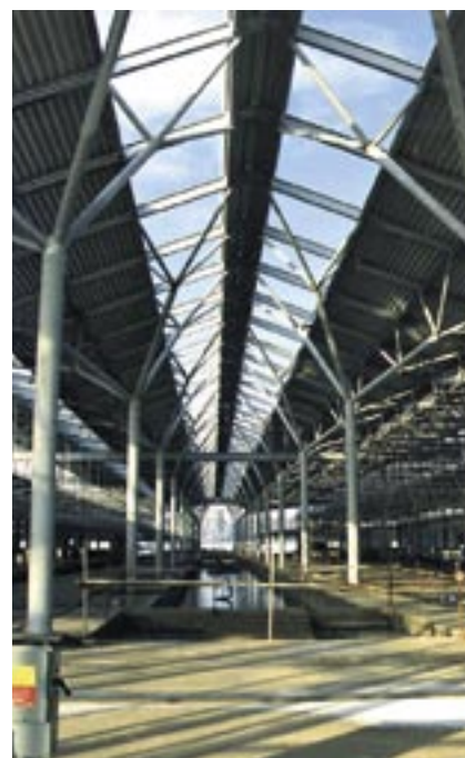
„Stromová konstrukce“ střední části haly M13
