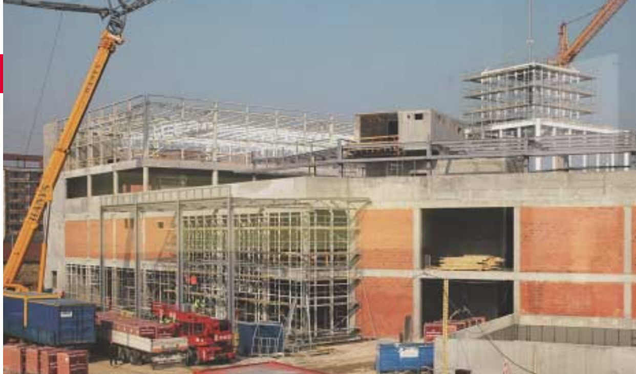
Obr. 1 - Pohled na přístřešek nad západním vstupem, administrativní budovu, sportcentrum a věž „Crystal tower“
