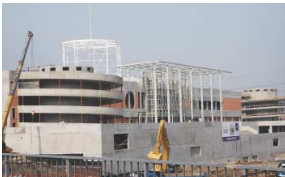
Obr. 2 - Pohled na ocelovou konstrukci opláštění fasády východního vchodu a rotundy
