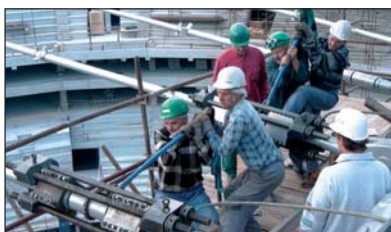
Obr. 8 – Sazka Arena, předpínání na volné délce.
