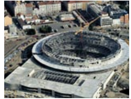
Ocelová konstrukce zastřešení haly Sazka Arena
