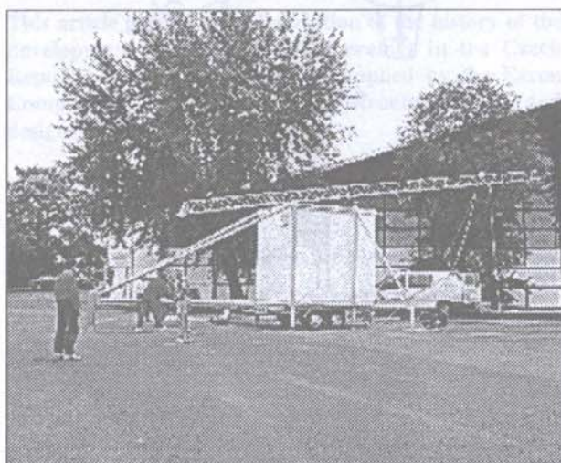
Obr. 16. Montáž mobilního stožáru s kontejnerem
