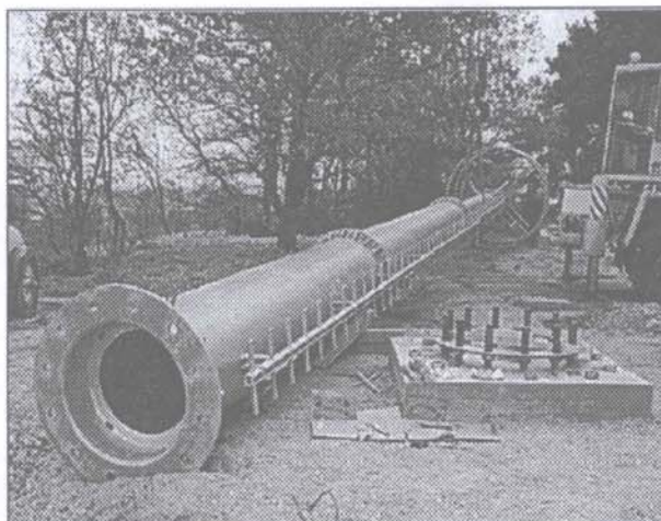
Obr. 7. Mirovice – věž ERE 25 m před montáží
