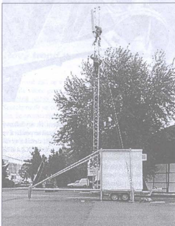
Obr. 17. Smontovaný mobilní stožár s kontejnerem
