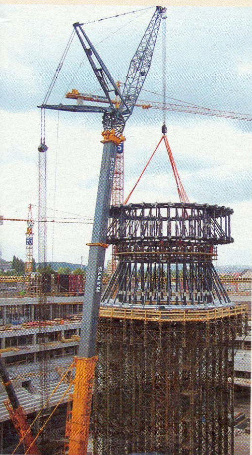
▼ Gigantický jeřáb Hanyš usazuje středovou část střechy
