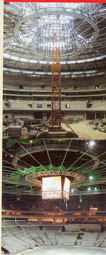
▲ Podpěra středové části byla odstraněna
