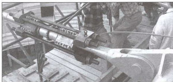
Obr. 16. Napínací zařízení u koncovy táhla
