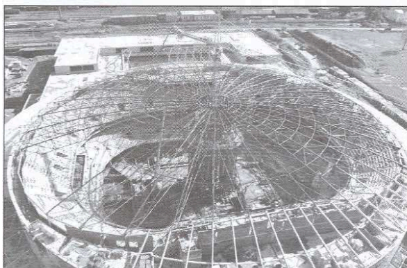
Obr. 1. Montáž konstrukce střechy s dočasnou střední podporou
