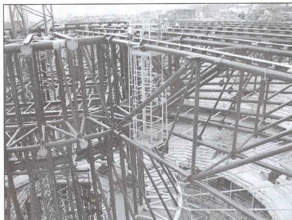
Obr. 5. Styk vazník-tubus
