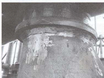
Obr. 8. Montáž tubusu na podpoře
