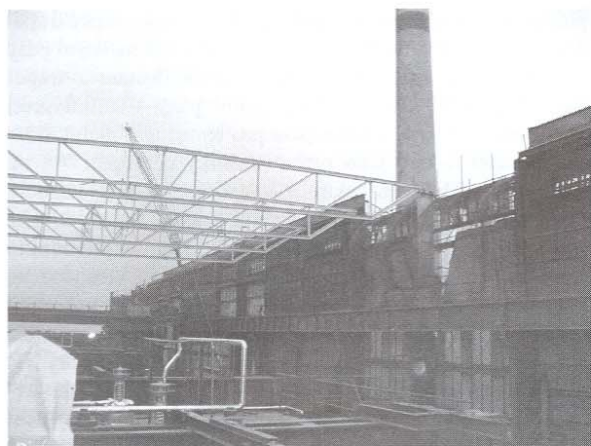
Obr. 8. Montáž vazníků, vpravo před komínem vyměněný horní dřev sloupu v řadě D
