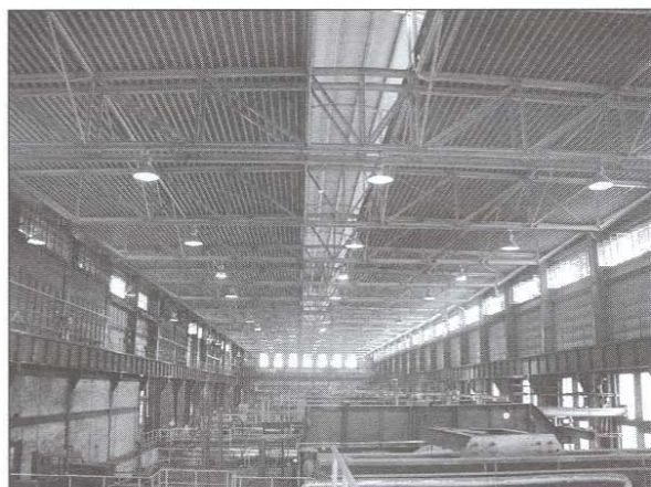
Obr. 9. Pohled do rekonstruované kotleny z kotle č. 4
