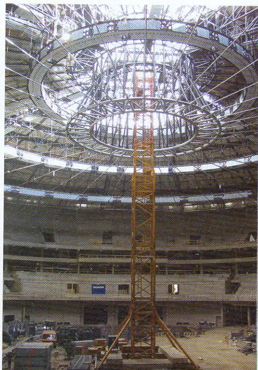
Střešní konstrukce po odstranění montážní podpory
