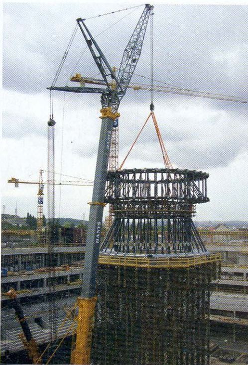
Usazení středového tubusu
