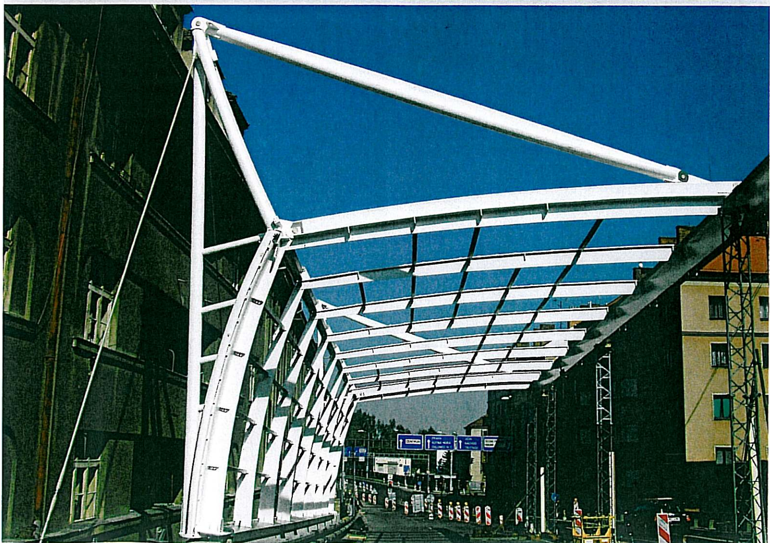
▼ Montážní podpory páteřního nosníku
