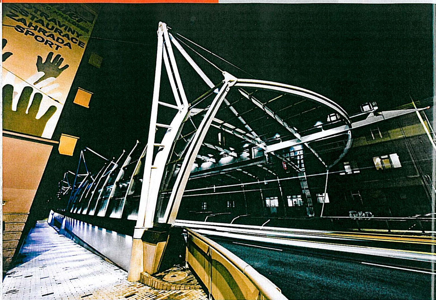
▲ Stavba protihlukového tunelu v Hradci Králové
