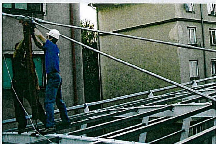
▲ Demontáž montážních podpor táhel
