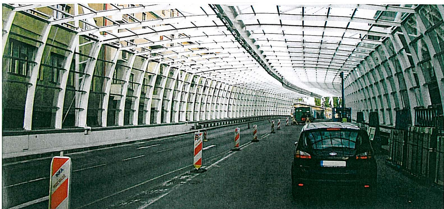
▲ Ocelová konstrukce po dokončení montáže a předpínání
