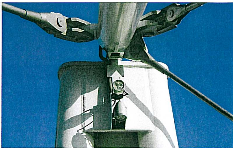
▲ Kotvení táhel u vrcholu sloupu
