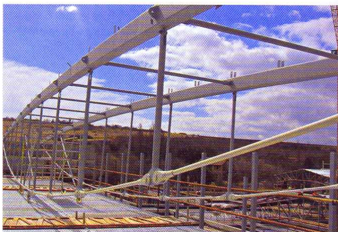
Vzpínadla o rozpětí třicet dva metrů po montáži
