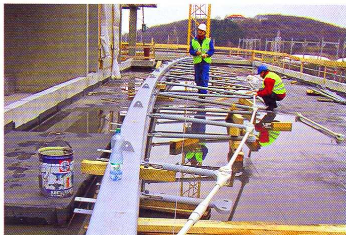
Vzpínadlo o rozpětí třicet dva metrů v poloze pro předmontáž a předpínání
