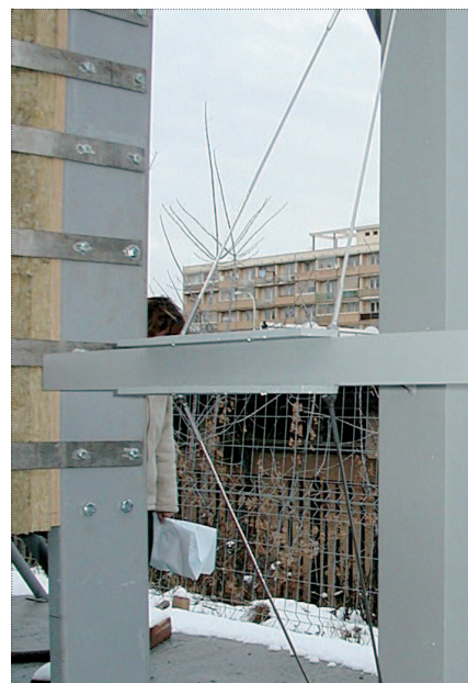
Obr. 2 – Detail zavěšení fasády – vzorek
