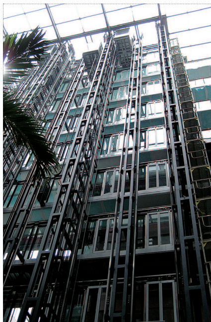
Obr. 4 – Ocelové konstrukce pro výtahy
