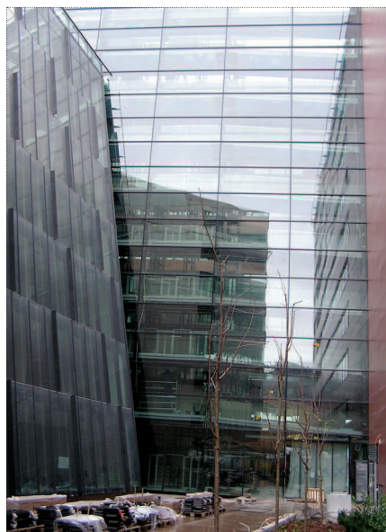
Obr. 1 – Zavěšená fasáda mezi dilatačními celky
