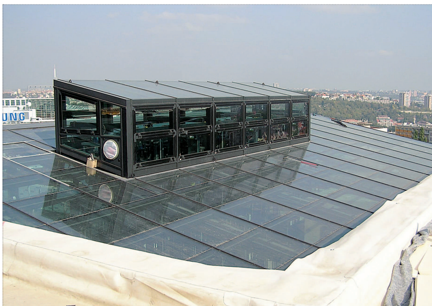
Obr. 6 – Střecha atria se strojovnou výtahů
