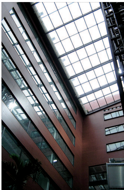
Obr. 3 – Střecha nad atriem
