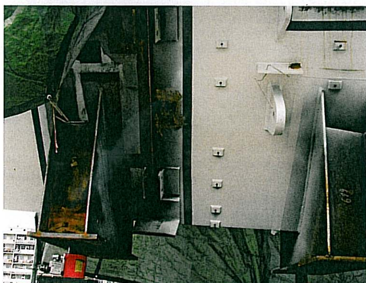
Obr. 10 – Spára před zavařením.
