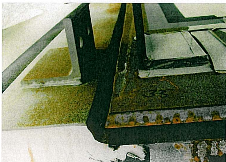
Obr. 11 – Spára před provedením svaru.
