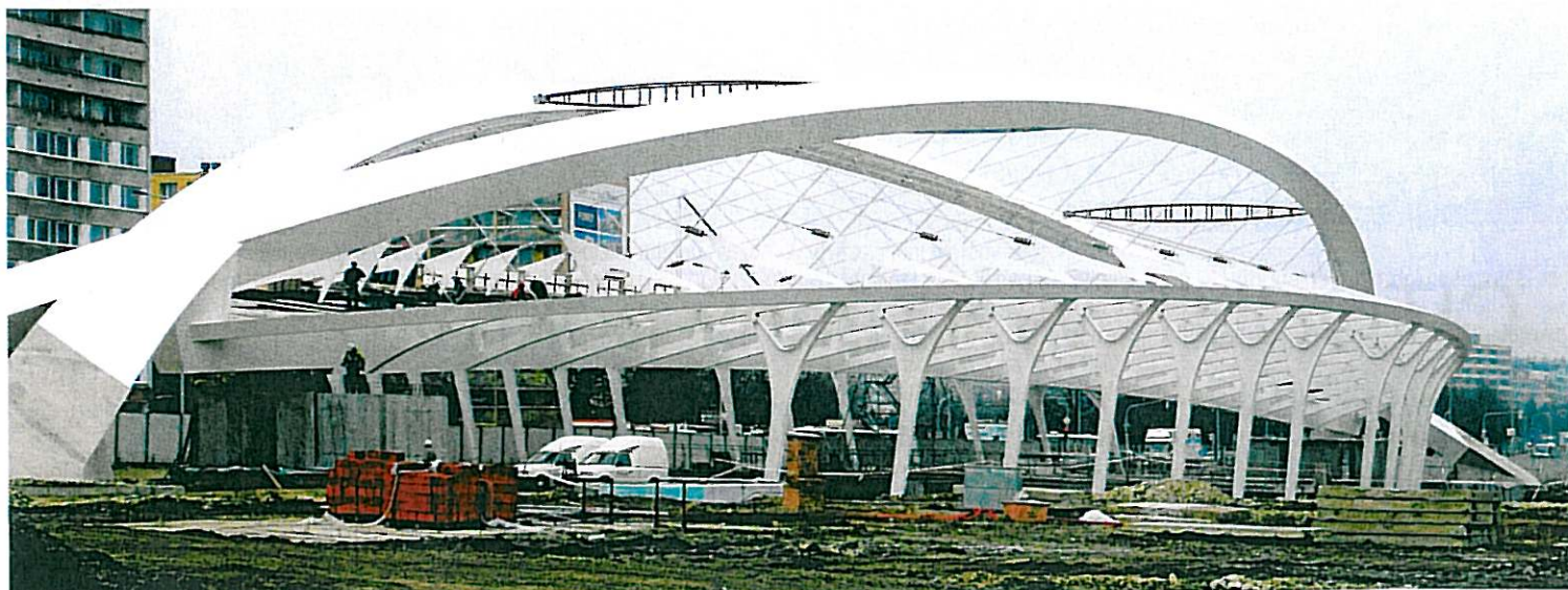
Obr. 1 – Pohled na smontovanou primární ocelovou konstrukci.
