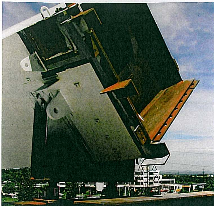
Obr. 9 – Úprava konce pro přípoj klenáku.
