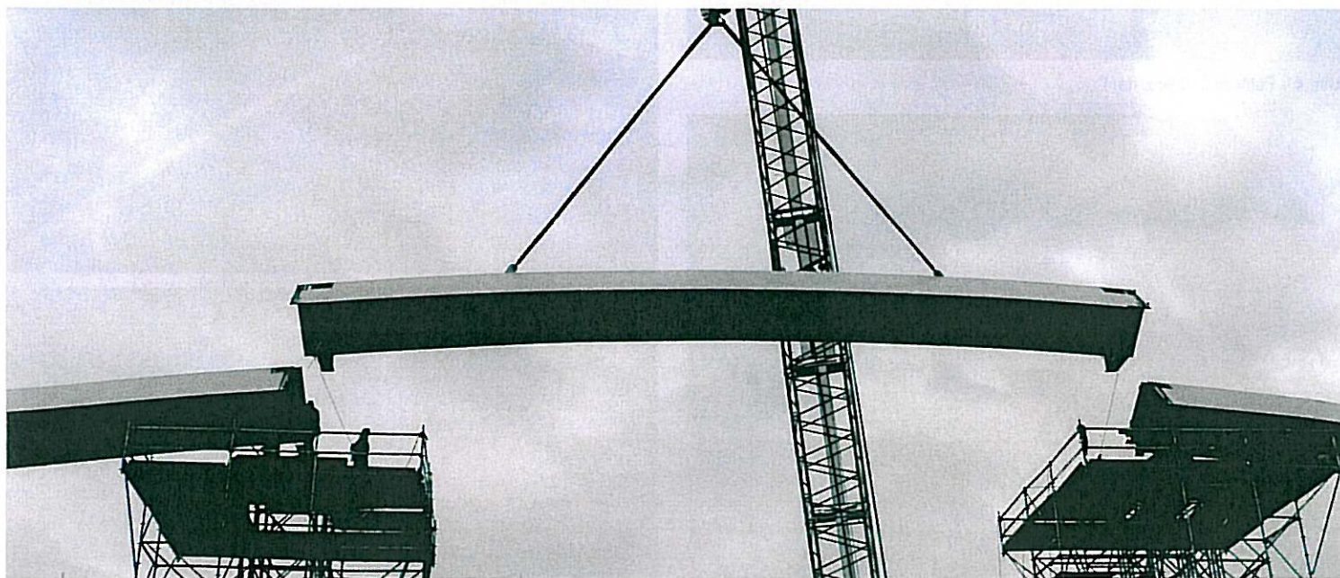
Obr. 8 – Usazování klenáku.
