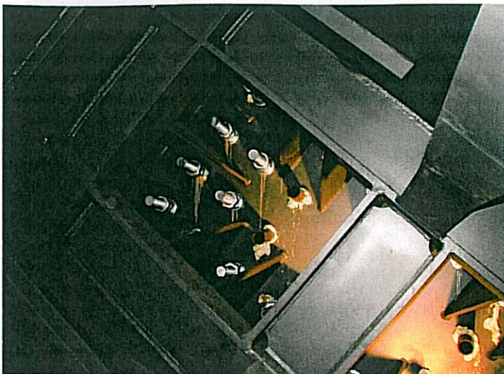
Obr. 3 – Detail prstence a výztuh kotvení.
