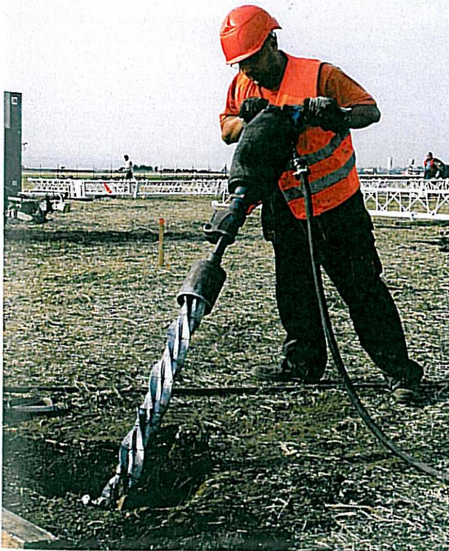
Příprava na kotvení
