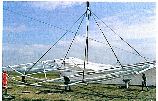
Montáž plachty na konstrukci
