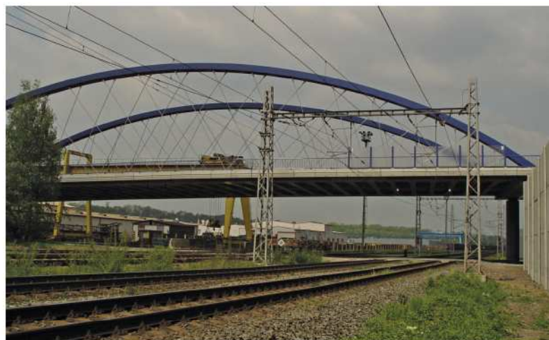
▼ Pohled na SO 201 od trati ČD
