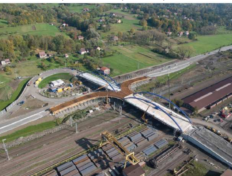
▼ Soumostí před betonáží srdcovky SO 202 a ramp SO 203 a SO 204
