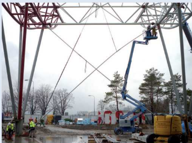
Obr. 10 – Aktivování střešních a stěnových táhel
