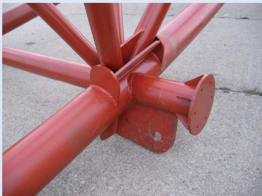
Obr. 3 – Složitě styčníky vazníků byly modelovány MKP.
