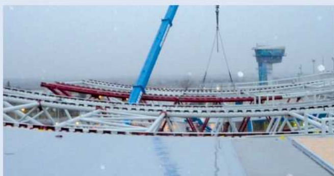
Obr. 11 – Aktivování střešních a stěnových táhel
