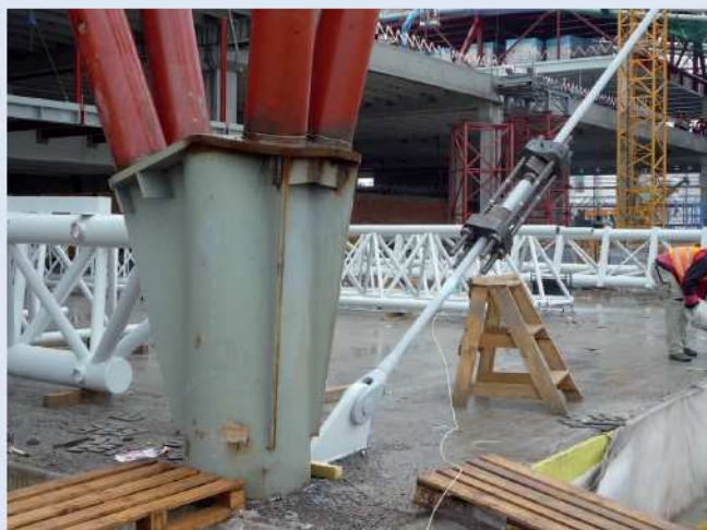
Obr. 12 – Předpětí táhel pomocí hydraulického zařízení
