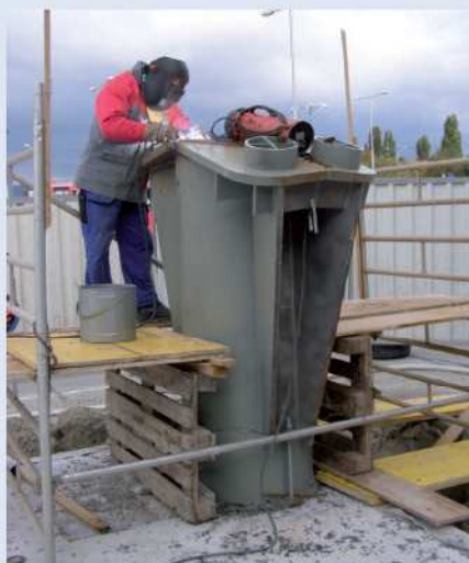
Obr. 5 – Dovaření vrchních plechů patky
