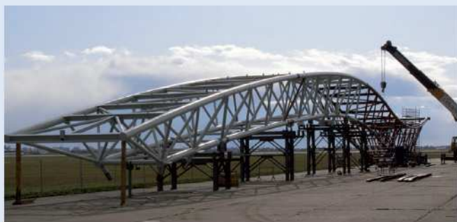
Obr. 8 – Sestavení přepravních dílů vazníku na předmontáži
