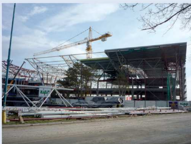
Obr. 13 – Konstrukce před propojením zavětrovaných částí
