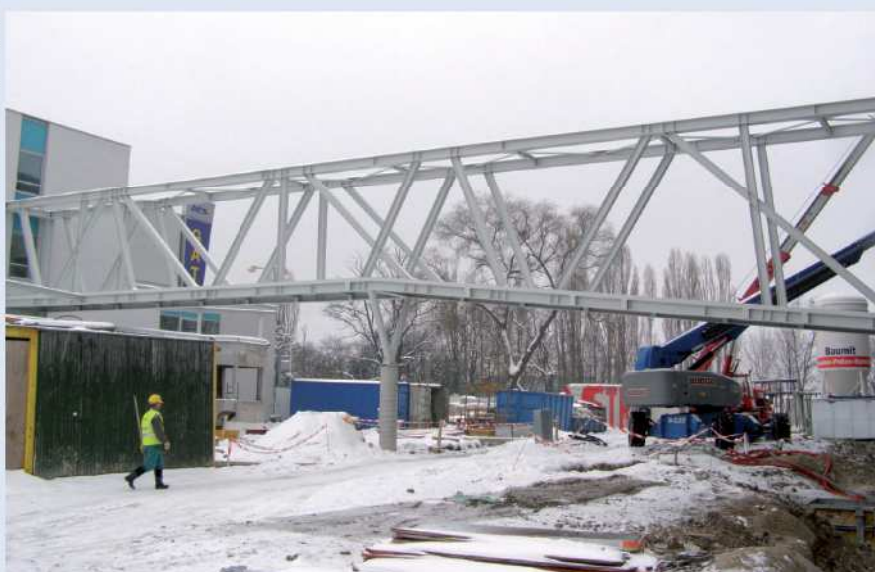
Obr. 20 – Most D má svařované prvky stěn.
