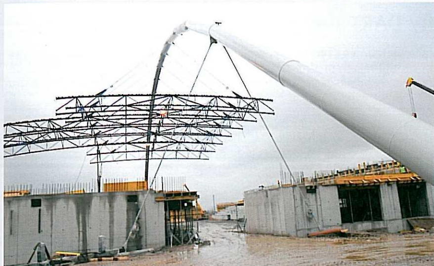
Zavěšení části střešní ocelové konstrukce pomocí táhel Macalloy
