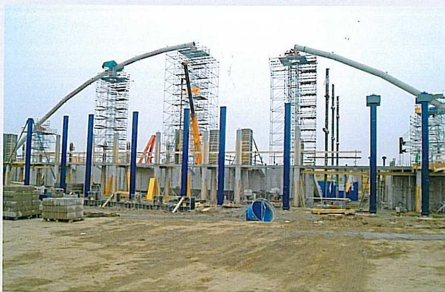
Montáž hlavního nosného oblouku
