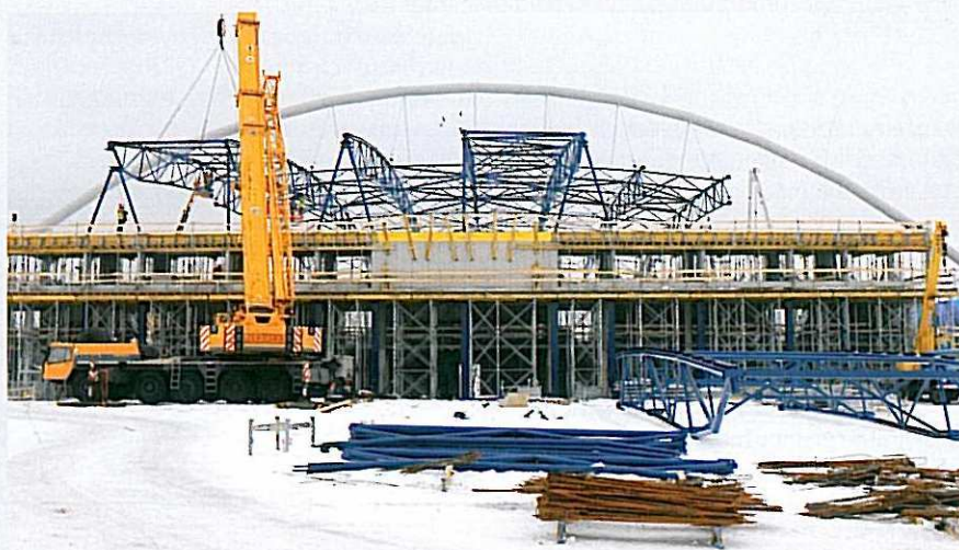
S ohledem na postup výstavby bylo potřeba krajiní části vazníků namontovat vždy po dokončení příslušné betonové tribuny.
