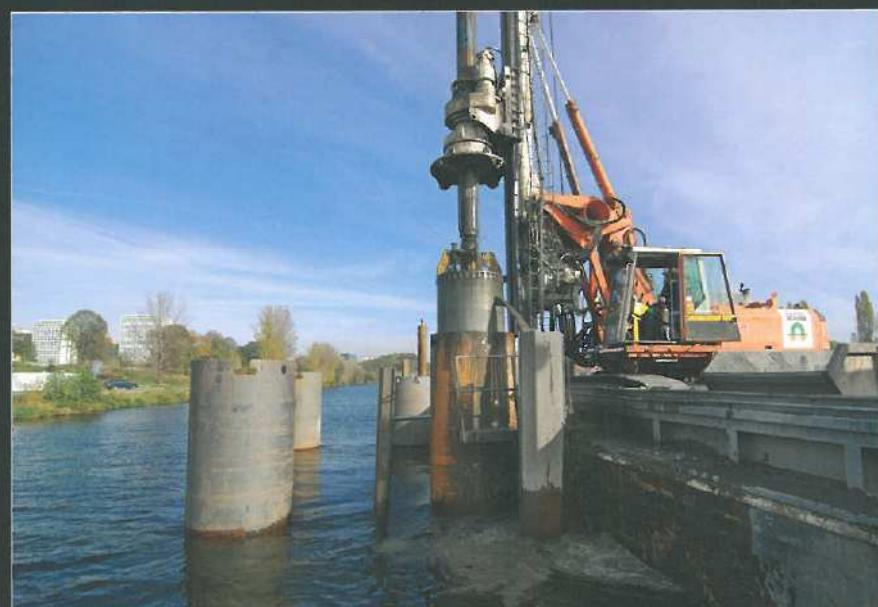
Práce na vodě byly náročné na provádění m. i proto, že piloty bylo nutno zhotovit s maximální půdorysnou odchylkou  $\pm 50$  mm
