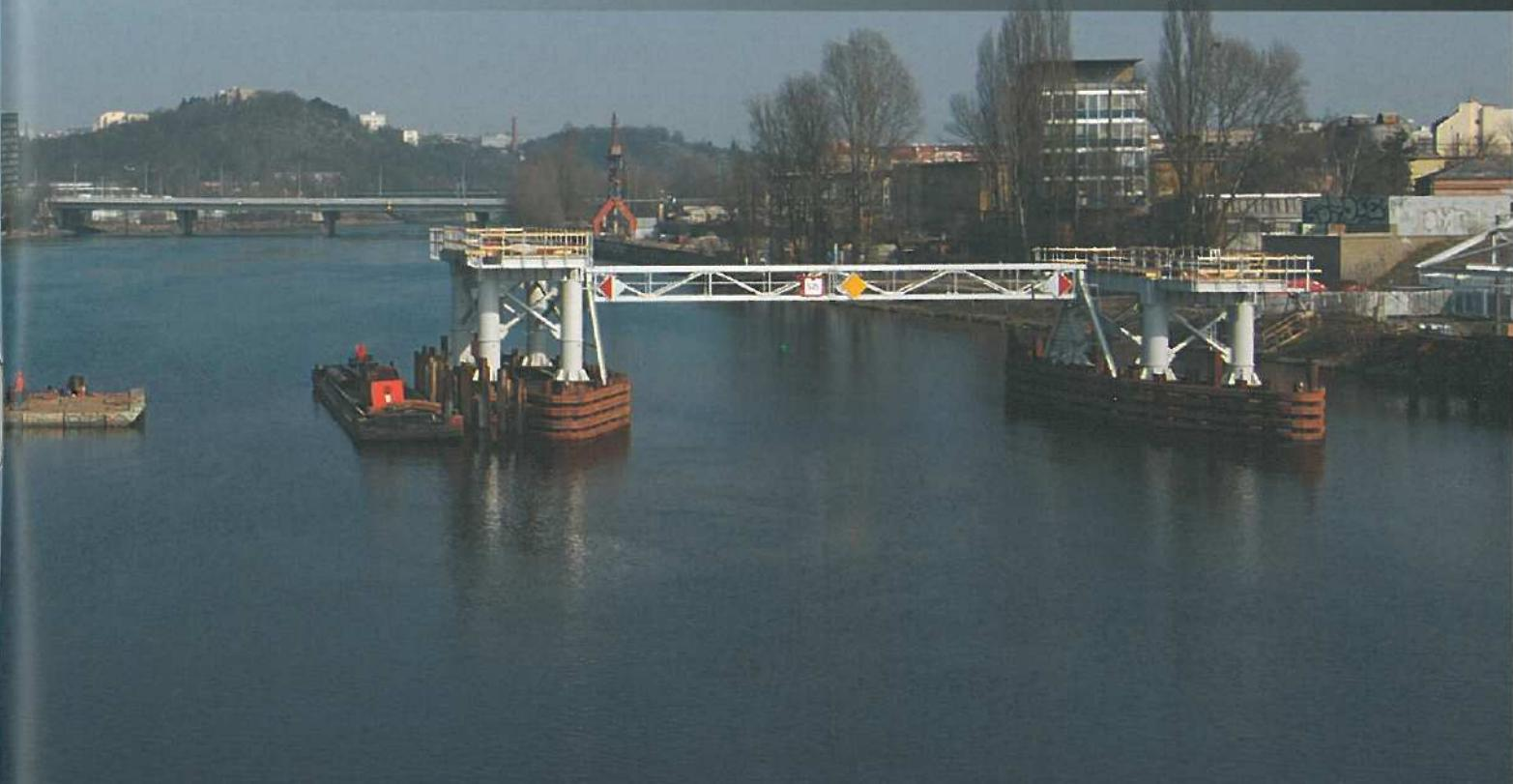
mostu, vyztužená prefabrikovanými příčníky. Nosná konstrukce hlavního mostu je příčně a podélně předepjatá. Oblouk je podepřen na holešovické podpěře a na pilíři na trojském břehu, na který navazuje druhé, krátké pole mostu (cca 40 m). Štíhlý oblouk je propojen s deskou mostu hustou sítí závěsů. Celý systém je velmi lehký, poměrně složitý na výstavbu a vyžaduje velmi přesné provádění konstrukce.
