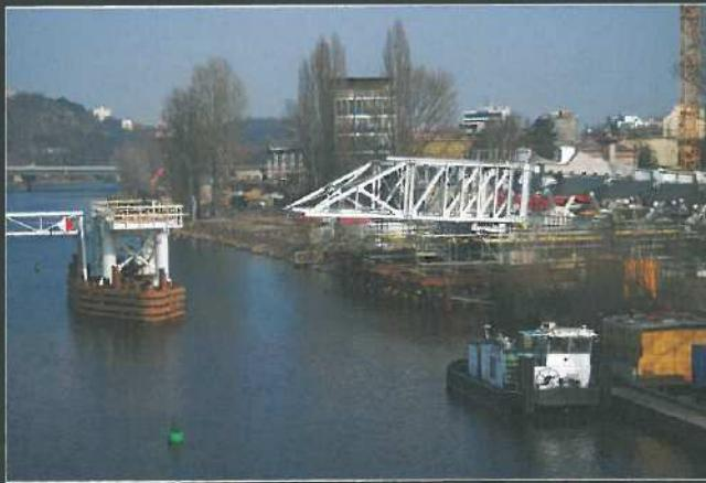
Zahájení výsunu nosné konstrukce z holešovického břehu
