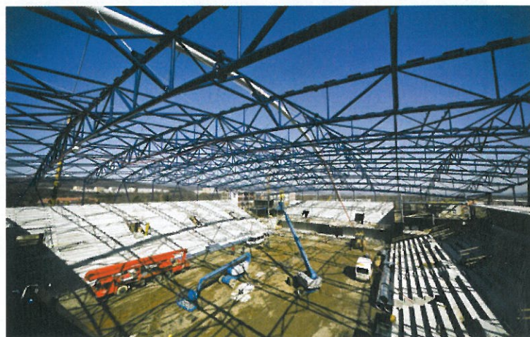
▲ Pohled na střešní konstrukci z interiéru stavby
