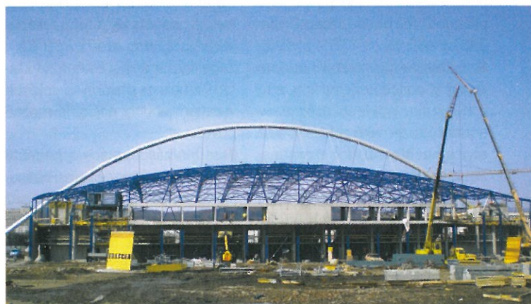
▲ Střešní konstrukce stavby zimního stadionu po dokončení montáže v Chomutově
