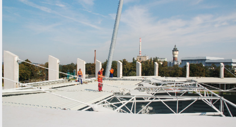
▲ Střešní konstrukce tribun. Horní trubkové pasy byly nahrazeny profily HEA, jež umožňují uložení trapézového plechu střešního pláště bez dalších úprav detailů. Táhla systému Macalloy 460 nahradila závěsy z trubek.
