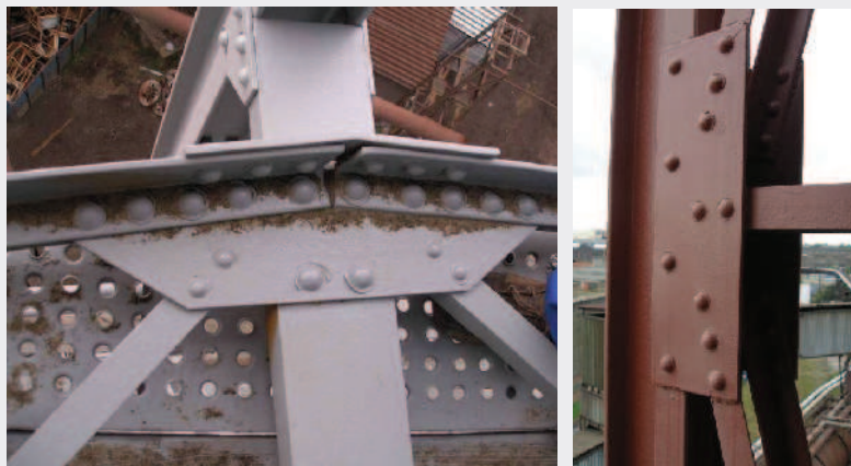
▲ Detail styčnicku lávky +20,3 m po otryskání a po aplikaci základního nátěru PKO
