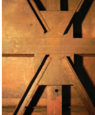
▲ Stěna zvonu plynojemu (vizualizace), detail styku prvků stěny
