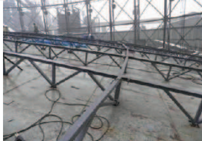
▲ Nové zesilující příhradové nosníky na střeše
