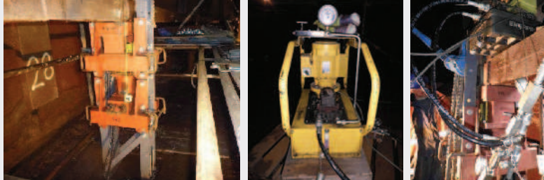
▲ Zdvih zvonu plynojemu, montážní nosníky, hydraulická jednotka
