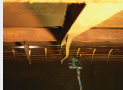
▲ Imperfekce spodních pasů příhradových nosníků
