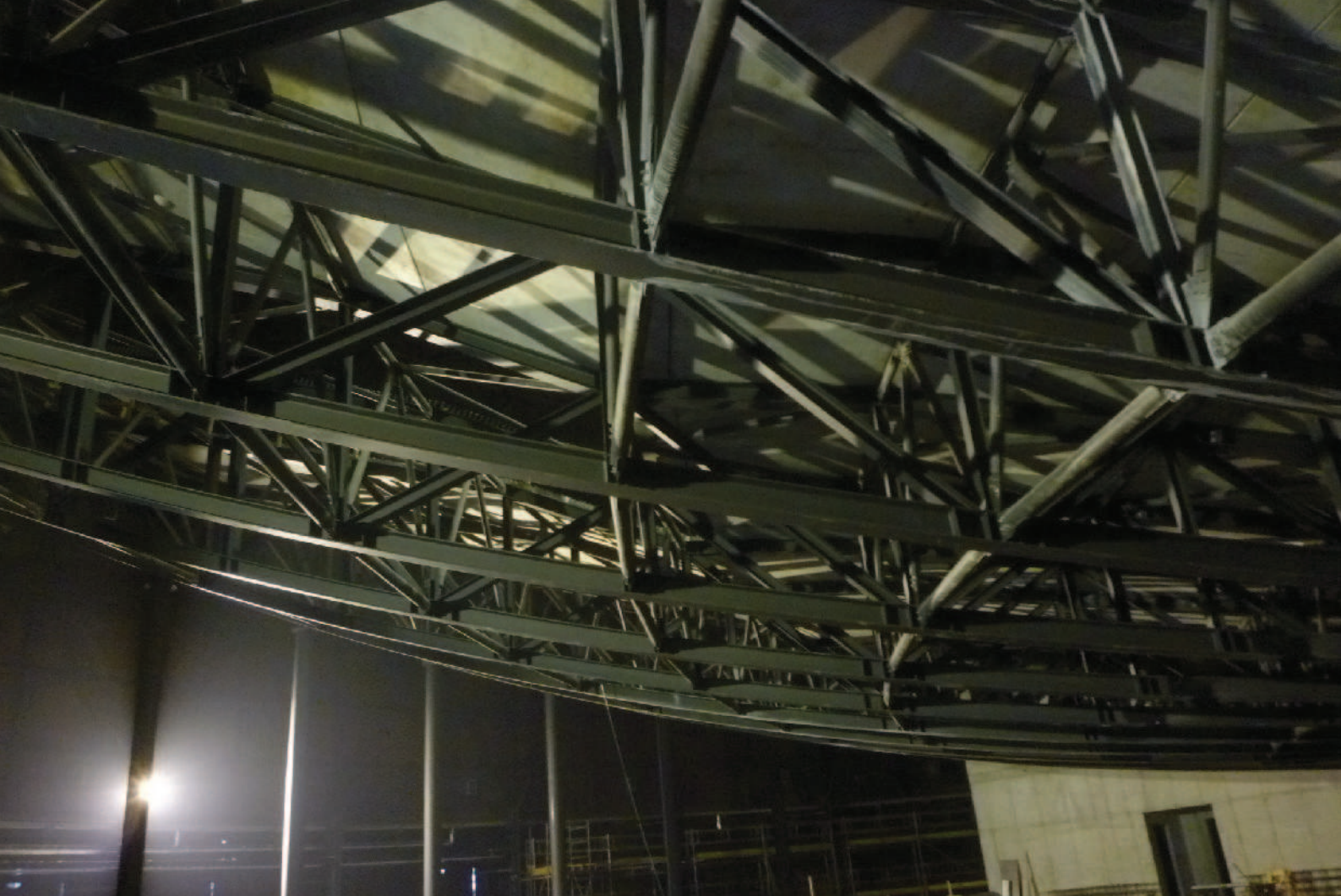
▲ Ocelová konstrukce hlediště
