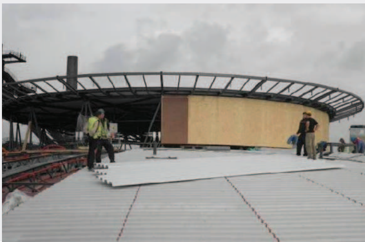
▼ Provizorní opláštění stěny tamburu a opláštění střechy zvonu plynojemu
