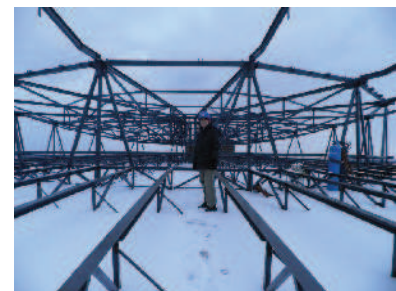
▲ Nová konstrukce tamburu (celkový průměr s konzolou činí cca 25,5 m)
