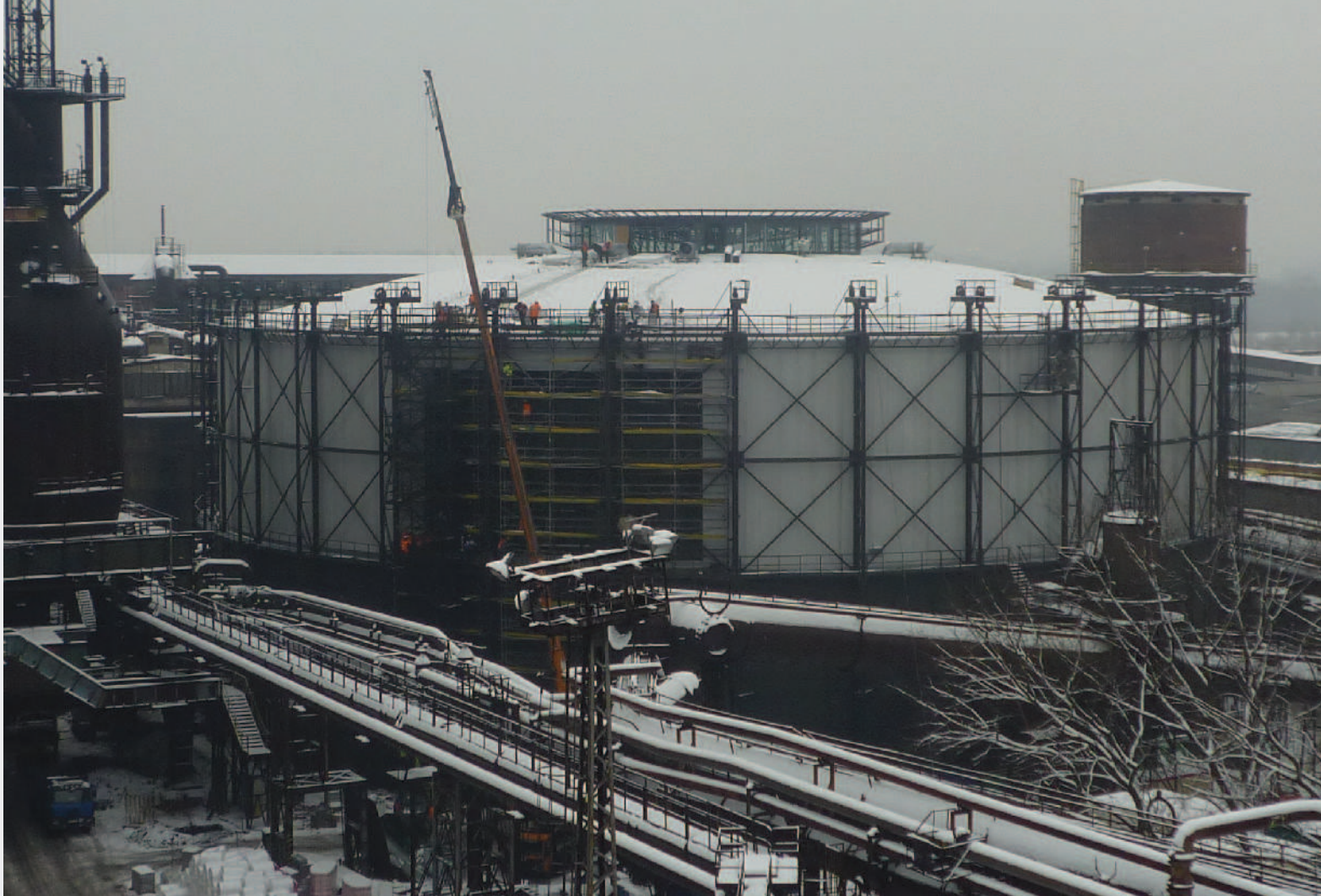
▲ Plynojem po opláštění, montáž zasklení otvoru za jevištěm
