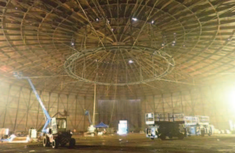
▲ Nové prostorové vzpínadlo, s prstencem o průměru 22,6 m
