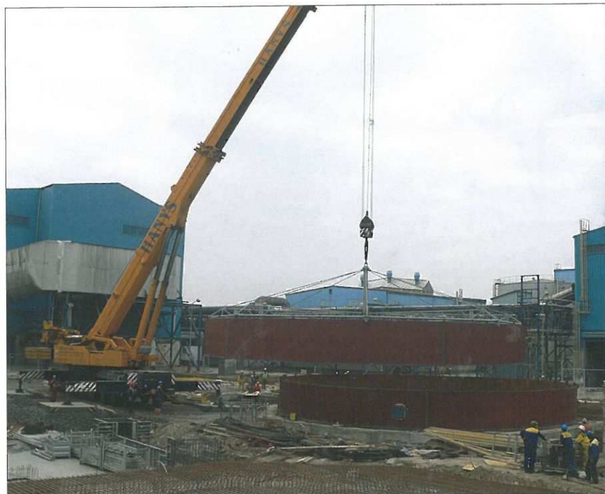
Montáž segmentů absorberu pomocí přípravku
