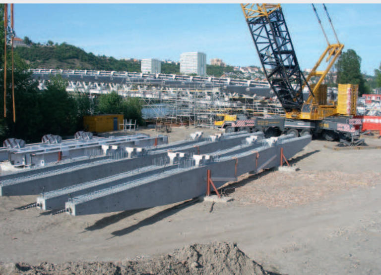
▼ Obr. 11. Prefabrikované příčnický na skládce
