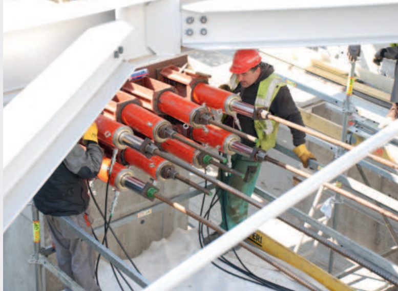
▲ Obr. 4. Válce pro výsuv nosného roštu mostovky
