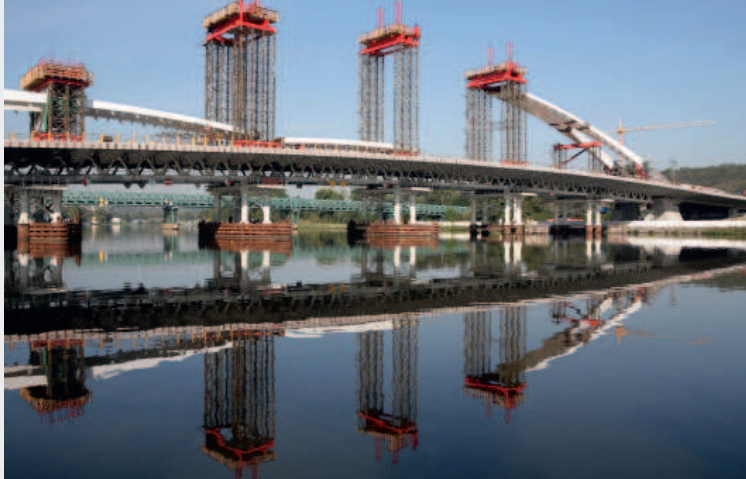
▲ Obr. 8a. Zvedání krajního dílu oblouku na trojské straně
