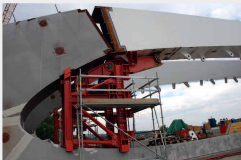
▼ Obr. 7b. Krajní díl oblouku osazený v čepu
