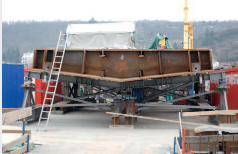
▲ Obr. 14. Pohled na průřez oblouku ve střední části
