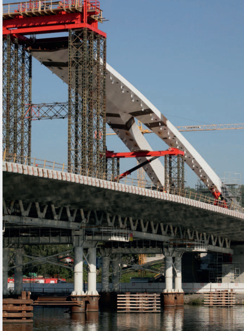
▲ Obr. 8b. Zvedání krajního dílu oblouku na trojské straně
