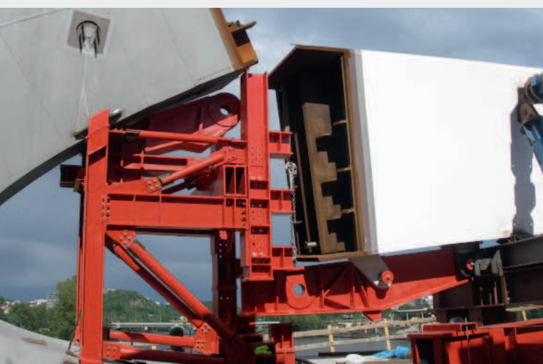
▼ Obr. 7a. Krajní díl oblouku v dopravní poloze
