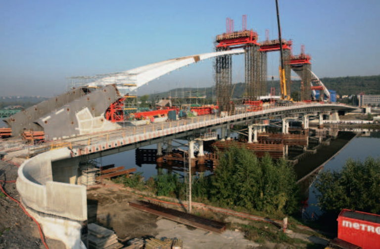
▲ Obr. 9. Stav, kdy bylo dokončeno zvedání obou krajních dílů
