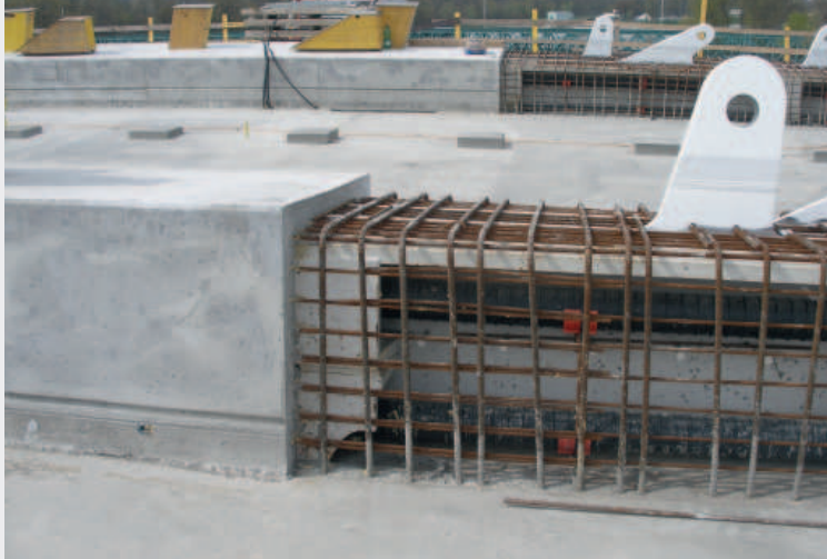
▲ Obr. 13. Táhl o oblouku před a po betonáži
