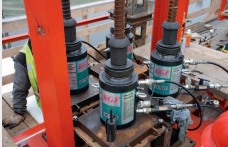
▲ Obr. 10. Duté hydraulické válce zvedající část oblouku na závěsných tyčích
