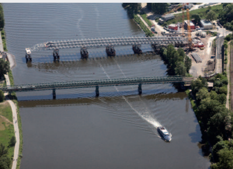
▲ Obr. 5. Letecký snímek vysouvané konstrukce
