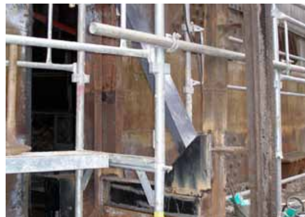
Obr. 16: Zesílení sloupů, včetně kotvení v místě velkoplošného otvoru
