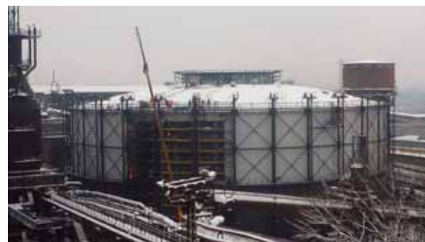
Obr. 18: Plynojem po opláštění, montáž zasklení otvoru za jevištěm
