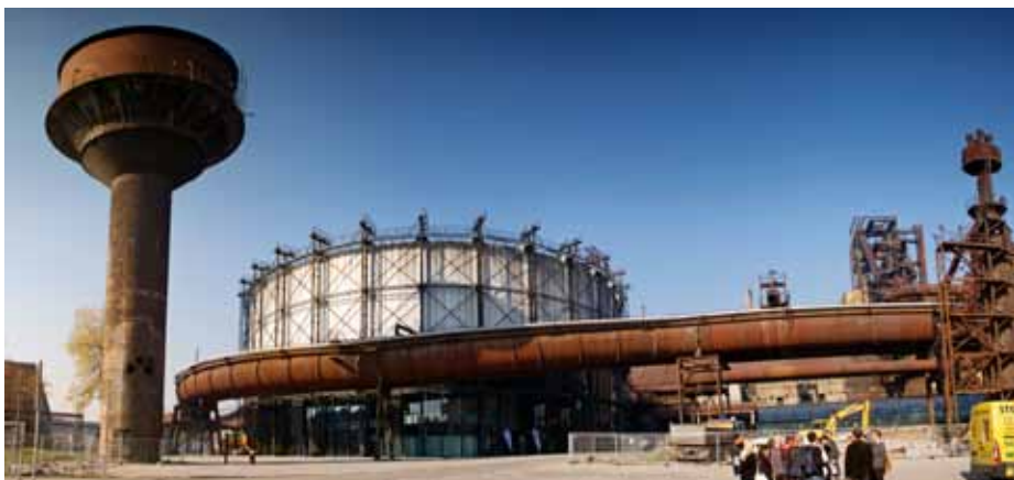
Obr. 29: Celkový pohled na dokončený plynojem
