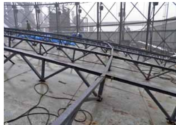
Obr. 6: Nové zesilující příhradové nosníky na střeše
