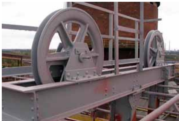
Obr. 12: Převáděcí kladky pro lana vyrovnávacího závaží po otryskání a aplikaci základního protikorozního nátěru
