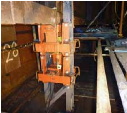
Obr. 9: Hydraulická jednotka pro zdvih
