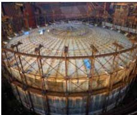
Obr. 11: Zvon plynojemu vyzvednutý zhruba z poloviny (+6,5 m)
