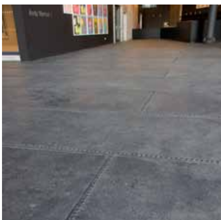
Obr. 25: Podlaha z původních nýtovaných plechů
