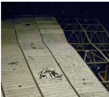
Obr. 20, 21: Filigránové desky na ocelové konstrukci hlediště
