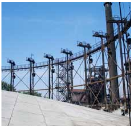
Obr. 5: Stav před rekonstrukcí – zvon plynojemu je spuštěný
