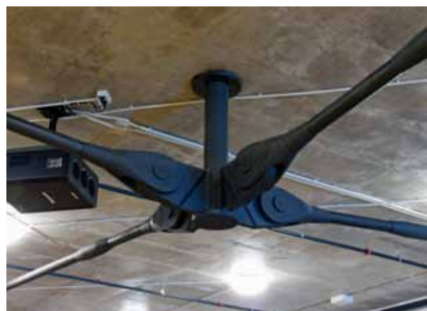
Obr. 24: Ocelové vzpínadlo z předpjatých táhel v místě „vynechaného“ sloupu
