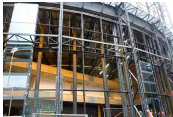
Obr. 17: Sekundární ocelová konstrukce pro opláštění (zasklení) velkoplošného otvoru
