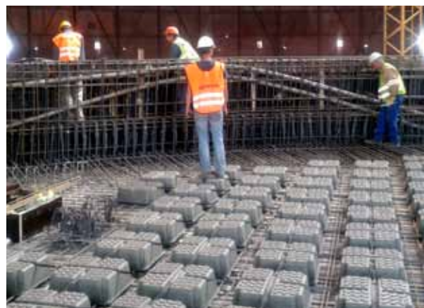
Obr. 22: Stropní konstrukce vylehčená tvarovkami U-boot
