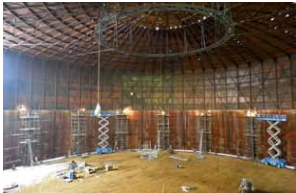
Obr. 8: Zdvihání zvonu plynojemu
