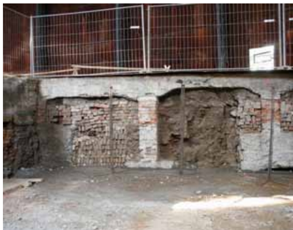
Obr. 14, 15: Původní základové konstrukce
