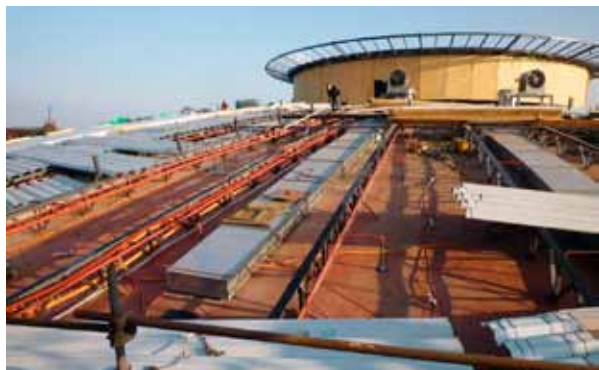
Obr. 10: Montáž opláštění střechy zvonu plynojemu a provizorní opláštění stěny tamburu
