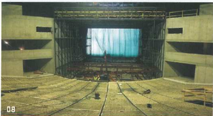
07 > Opláštěný plynojem s montáží prosklení velkoplošného otvoru 08 > Jeviště a hlediště s filigrány 09 > Lasturovitý tvar příhradové konstrukce hlediště 10 > Montáž zasklení u vstupu
