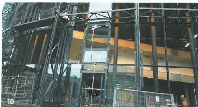
07 > Opláštěný plynojem s montáží prosklení velkoplošného otvoru 08 > Jeviště a hlediště s filigrány 09 > Lasturovitý tvar příhradové konstrukce hlediště 10 > Montáž zasklení u vstupu
