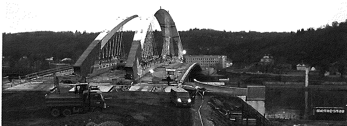
Obr. 1 Trojský most, stav 02/2013
