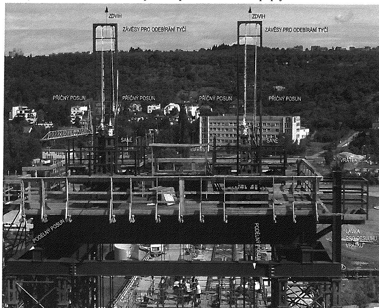
Obr. 7 Hlavice provizorní věže
