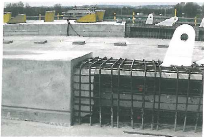
Ryc. 14. Ciężno łuku przed i po betonowaniu
