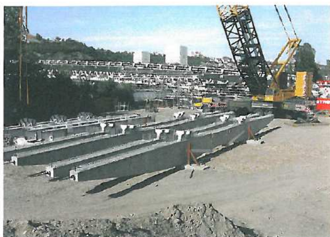
Ryc. 12. Poprzecznic prefabrykowane na składzie
