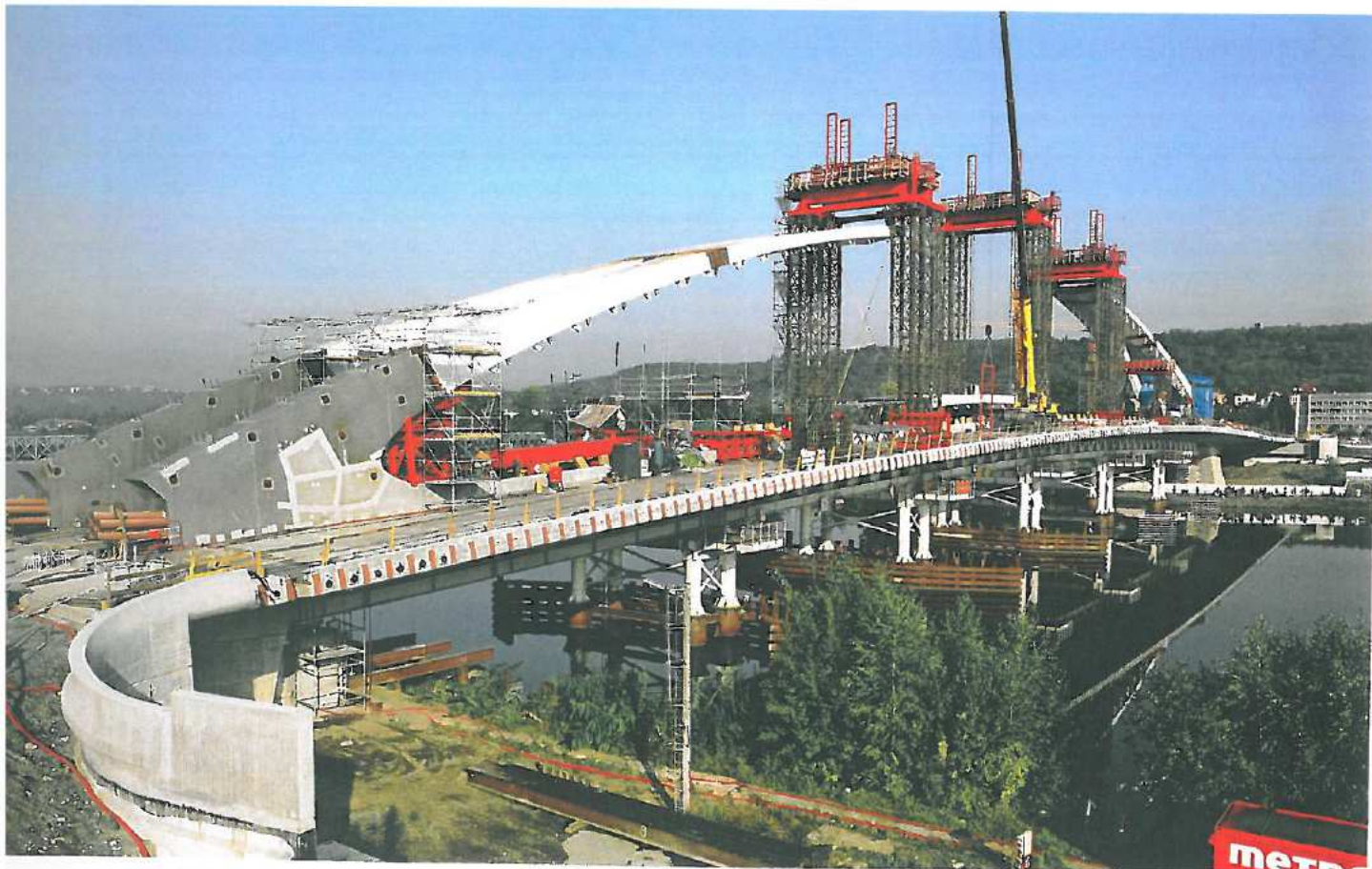
Ryc. 10. Stan robót po wzniesieniu obu części skrajnej tuku
