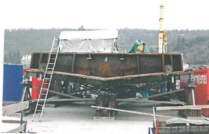
Ryc. 15. Przekrój łuku w części środkowej
