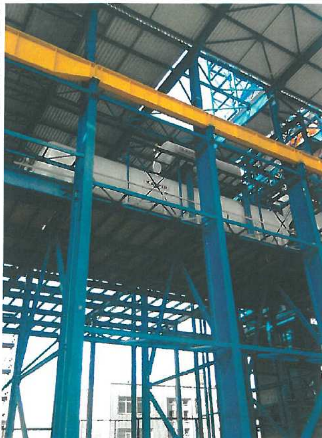
Obr. 10 – Pohled vnitřní sloupy s jeřábovou dráhou haly spalovacích turbín
