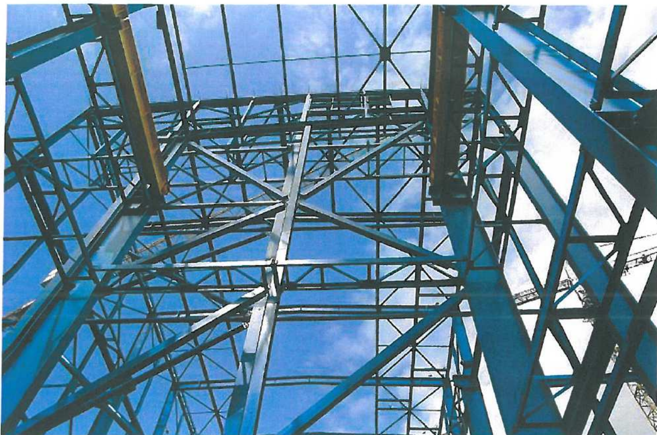
Obr. 9 – Pohled na koncové příčné ztužidlo haly spalovacích turbín
