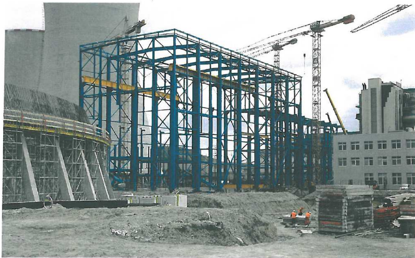
Obr. 3 – Ocelový skelet strojovny parní turbíny před montáží opláštění
