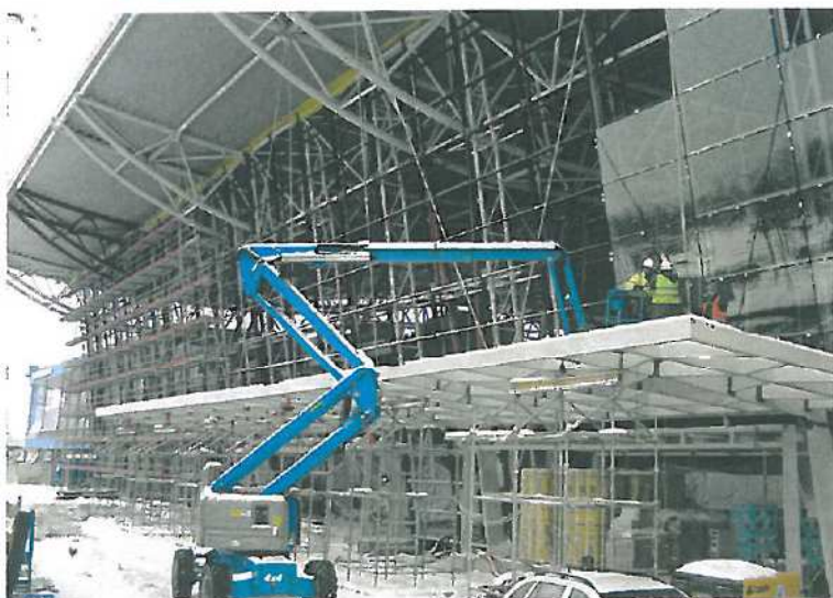
Obr. 8 – Foto z montáže markýzy
