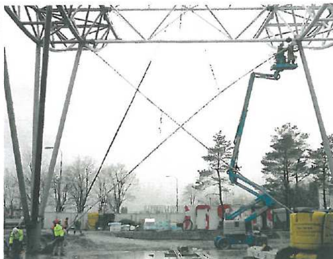
Obr. 7 – Foto z montáže táhel
