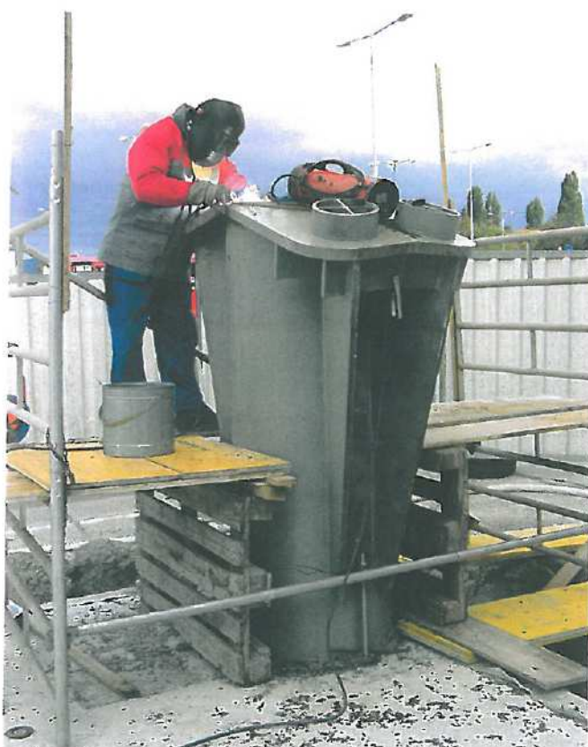
Obr. 4 – Detail patního styčnicku sloupů
