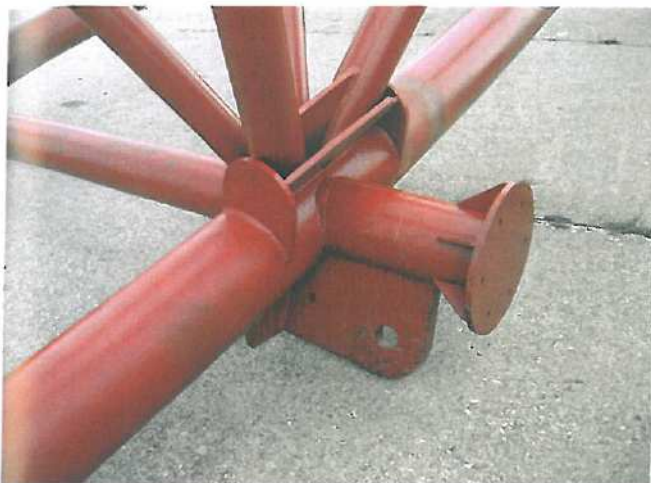
Obr. 3 – Detail prostorového styčnicku
