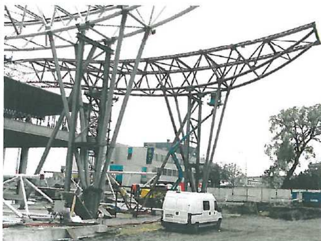
Obr. 6 – Foto z montáže vazníků
