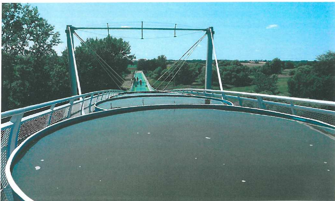
Obr. 14 – Zaťažovanie konštrukcie počas základnej statickej zaťažovacej skúšky
