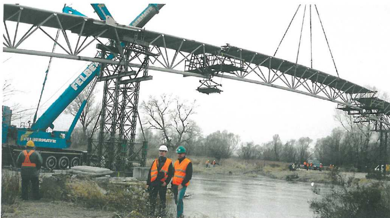
Obr. 12 – Uloženie záverečného dielca hlavného poľa
