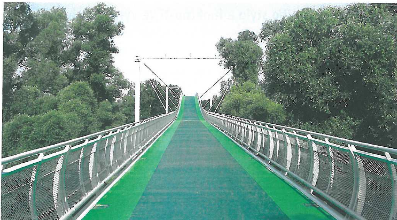
Obr. 15 – Pohľad na dokončený most
