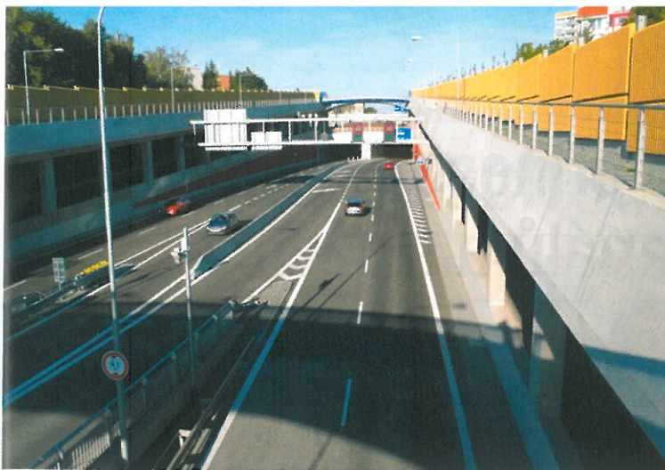
▲ Silnice I/42 Brno, VMO Dobrovského
