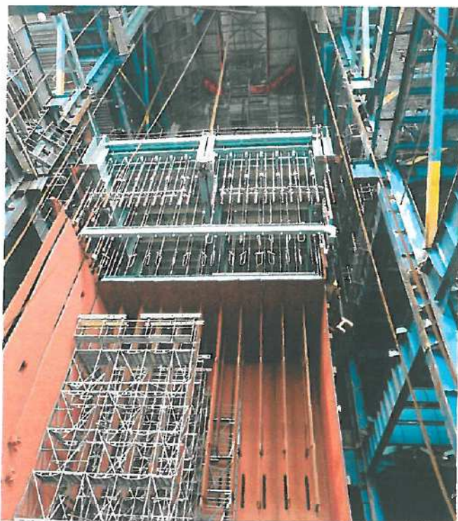
Montáž nové spalovací komory – současnost
