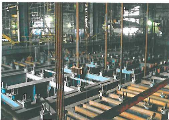
Montáž nového roštu a závěsů II. tahu
