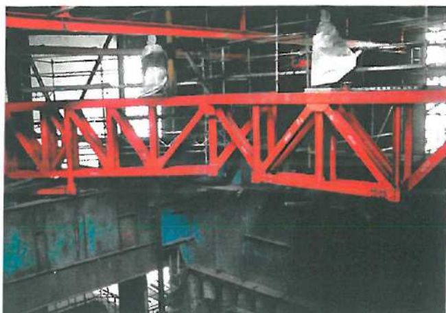
PPK po spuštění roštu s kotlem
