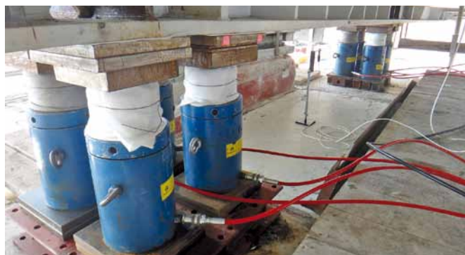
Celková nosnost hydrauliky byla 13 300 tun a každý pilíř byl vybaven snímači polohy.
