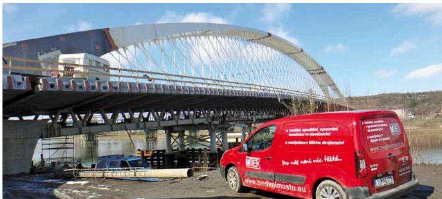
Trojský most po spuštění a 100% aktivaci závěsů
